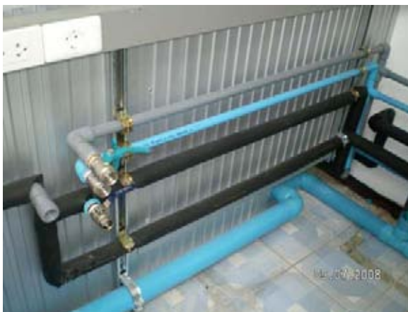
รูปที่ 5.8 การติดตั้งระบบน้ำเพื่อใช้ในการทดสอบ
