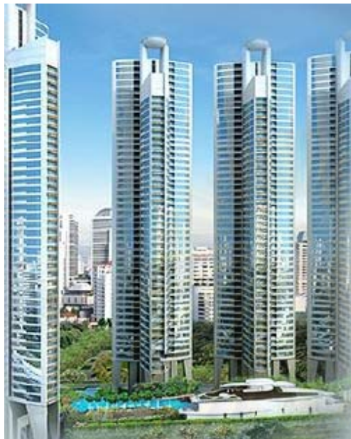
รูปที่ 3.31 โครงการก่อสร้างอาคารที่พักอาศัย MILLENNIUM RESIDENCE
