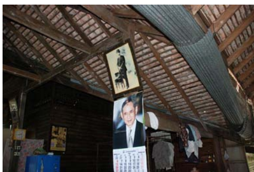
รูปที่ 3-138, 3-139 แสดงโพงสังกะสีที่ทำหน้าที่รับน้ำฝนและเชื่อมพื้นที่โล่งภายในเรือนแผดเข้าด้วยกัน
