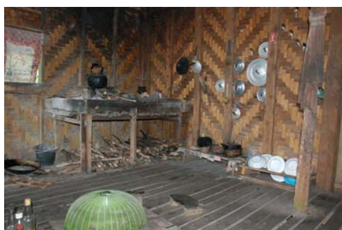
รูปที่ 3-126,3-127 การเก็บของในผนังด้วยการหนีบ และแขวนของใช้ต่างๆ กับผนังไม้ไผ่สาน เป็นการเพิ่มพื้นที่ใช้สอยในแนวตั้งวิธีหนึ่งเช่นกัน
