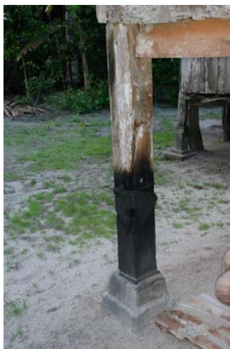
รูปที่ 3-173 วิธีการรองเสาเรือนด้วยผ้าชุบยางไม้เพื่อกันปลวกขึ้นเรือน
