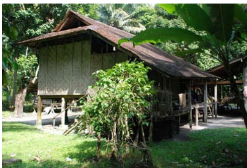
รูปที่ 3-377 แสดงการขยายชายหลังคาด้านเดียว หลังคาแม่เรือนทรงหัวกะโหลเล็ก (จั่วมะนิลา)
