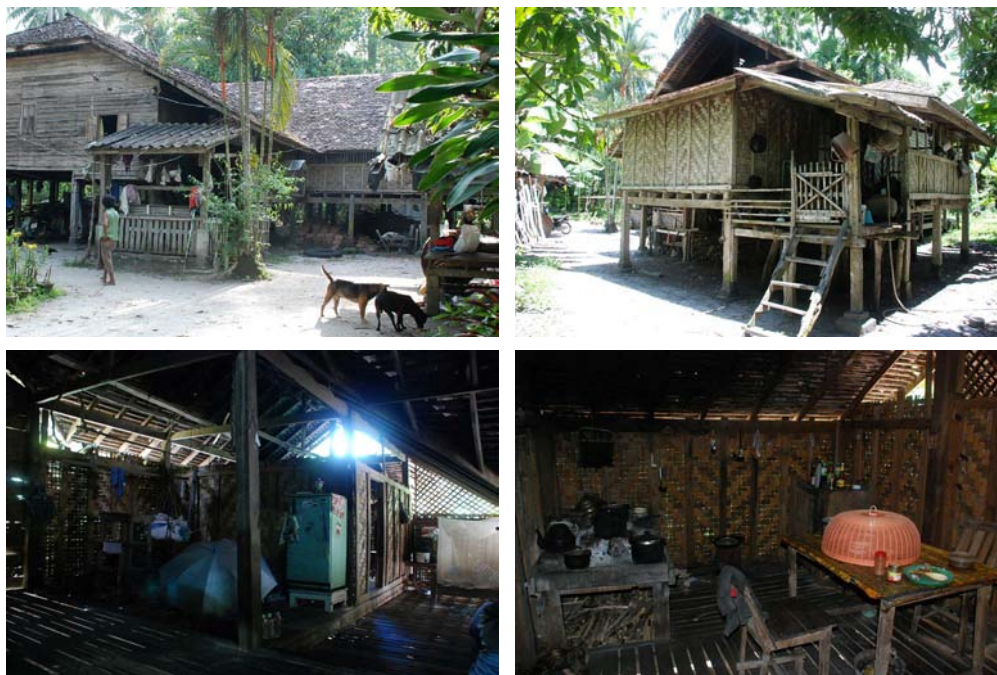
รูปที่ 3-49, 3-50, 3-51, 3-52 ห้องครัวอยู่ในส่วนที่เป็นมุขระเบียง ซึ่งขยายออกจากแม่เรือนและออกสงาบลดระดับพื้นในส่วนปลายของมุขระเบียงสำหรับวางแม่ตีไฟ ใช้ผนังไม้ไผ่สานและพื้นไม้เว้นร่อง
