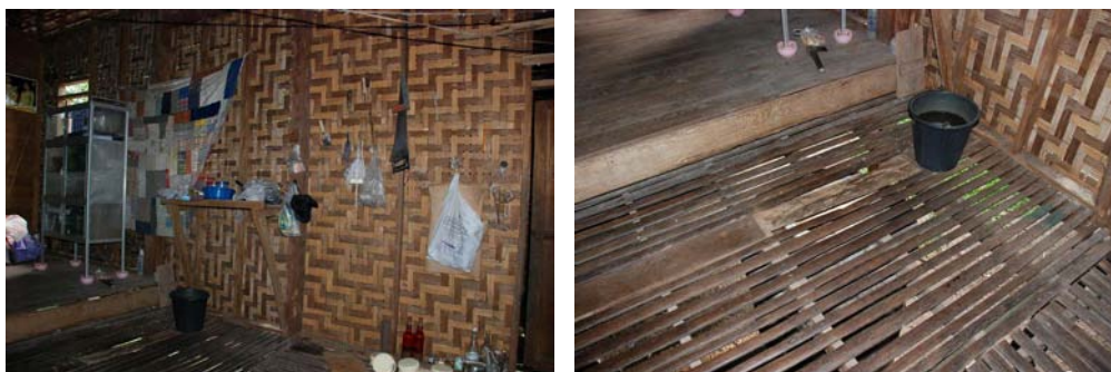
รูปที่ 3-71, 3-72 ห้องส้วมบนระเบียงเรือน สามารถเปิดแผ่นไม้เมื่อใช้งานและปิดได้
