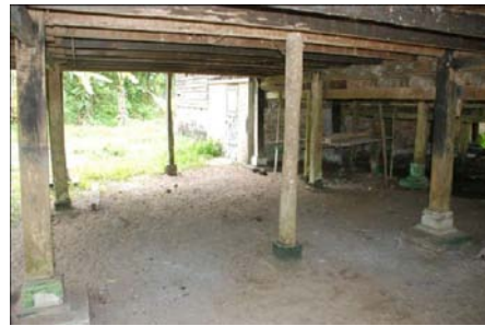
รูปที่ 3-203 เสาภูมิ (เสาค้ำที่อยู่กึ่งกลาง)
