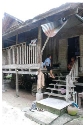
รูปที่ 3-112, 3-113 นอกชานหน้าบ้านใช้รับแขก ส่วนนอกชานหลังบ้านใช้สำหรับงานซักล้างต่างๆ เรือนนี้เป็นนอกชานเปิดโล่ง ไม่มีหลังคาคลุม มีรูปแบบเหมือนเรือนสมัยโบราณ วัสดุที่ใช้แบบดั้งเดิม คือใช้ต้นหมากทั้งต้นผ่าแบ่ง 4 ส่วน แล้วนำมาปูพื้น ซึ่งมีความทนทาน ประหยัดและสามารถทำได้ง่าย
