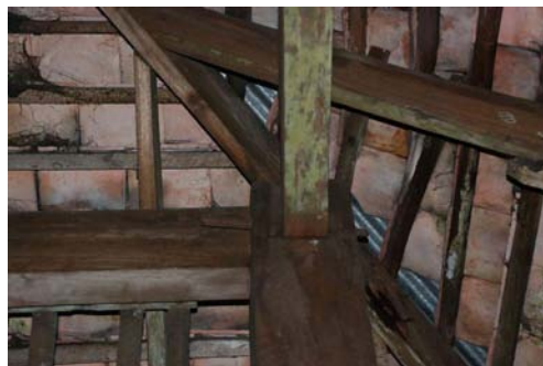
รูปที่ 3-143 ลูกสีกที่ยึดอะเสกับเสา
