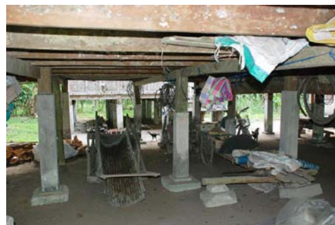
รูปที่ 3-259 เสาภูมิ(เสาค้ำต้นที่อยู่กึ่งกลาง)
