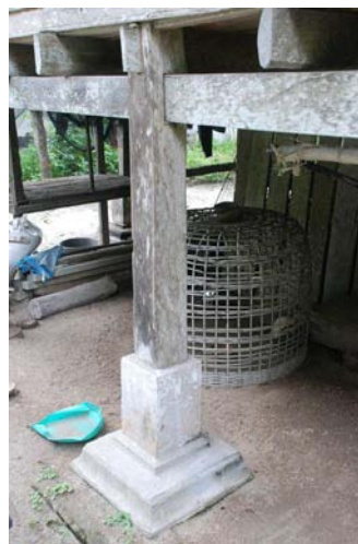
รูปที่ 3-174 การวางเสาเรือนบนดินเสานูน ทำให้สามารถสังเกตเห็นทางเดินของปลวกที่จะปรากฏบนดินเสาดได้
