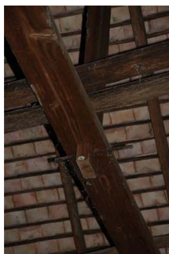
รูปที่ 3-141 ลูกสกที่ใช้ยึดชื่อกับดั่ง
