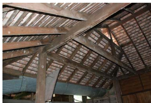
รูปที่ 3-138, 3-139 แสดงโพงสังกะสีที่ทำหน้าที่รับน้ำฝนและเชื่อมพื้นที่โล่งภายในเรือนแผดเข้าด้วยกัน
