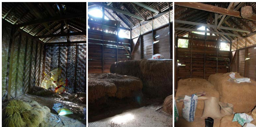
รูปที่ 3-34, 3-35, 3-36 ภายในเรือนข้าวจะใช้วัสดุและทำช่องเปิดให้มีความโปร่งเพื่อระบายความชื้น รูปขวาสุด แสดงการเรียงข้าวเป็นกอง และภาชนะที่ใช้ใส่ขี้ขี้ข้าวซึ่งจะถูกแขวนไว้ด้านบน
