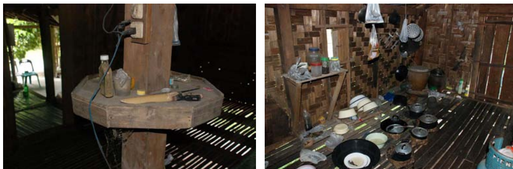
รูปที่ 3-130,3-131 การทำชั้นวางยึดกับเสาเรือน หรือผนังเรือนในการเพิ่มพื้นที่ใช้สอยในแนวตั้ง
