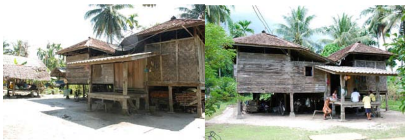
รูปที่ 4-16 แสดงการใช้ประตูบานเฟี้ยมในเรือนแฝด
