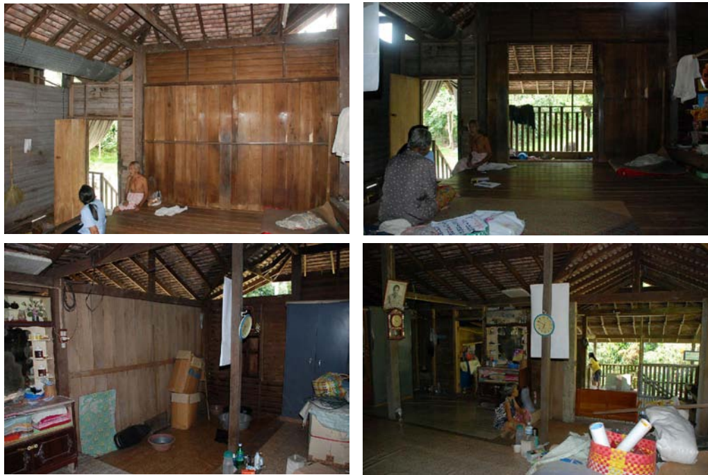
รูปที่ 4-17 แสดงให้เห็นการใช้ประตู 2 บานร่วมกัน คือประตูบานเปิด และประตูบานเพี้ยม ในเรือน 2 หลัง ซึ่งประตูบานเปิดจะใช้งานเป็นประจำ ส่วนประตูบานเพี้ยมจะเปิดใช้งานเมื่อต้องการเพิ่มพื้นที่ใช้สอยขนาดใหญ่ เพื่อเชื่อมพื้นที่ 2 ส่วนเข้าด้วยกัน
