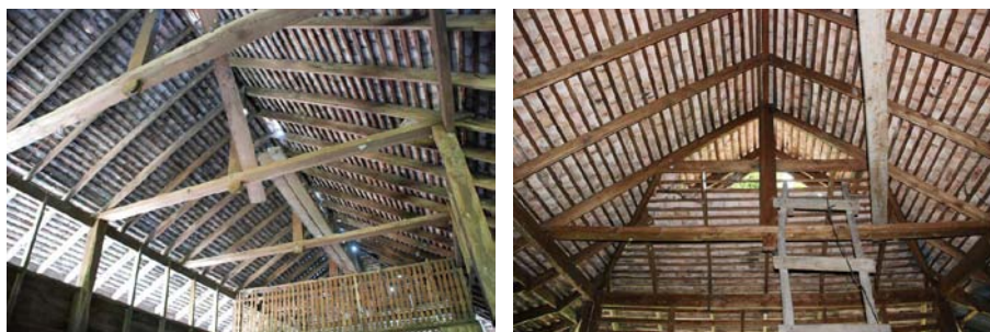
รูปที่ 3-6, 3-7 ไม้พาดชือที่พบในเรือรพื้นถึนไทยพุทศชวพว่ร่น รูปชวมือแสดงวิธีการขึ้นไปชอมหลังคท
