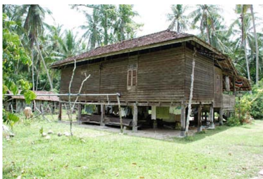
รูปที่ 4-12 แสดงลักษณะเรือนพื้นถิ่นไทยพุทธชาวพร่อน ที่ยกพื้นเรือน และทำใต้ถุนสูง เพื่อการระบายอากาศที่ดี และหนีจากความชื้นบนพื้นดิน
