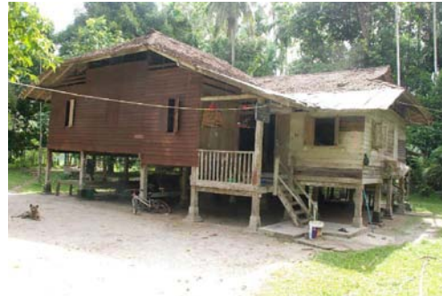
รูปที่ 3-380 แสดงการออกมุงเดี่ยวทรงซิก (ฉาก) และ ขยายชายหลังคาสองด้าน หลังคาแม่เรือนทรงหล้าทู่ห้า (ปั้นหย่า) มุขหลังคาทรงหัวกะโหลกเล็ก (จั่วมะนิลา)
