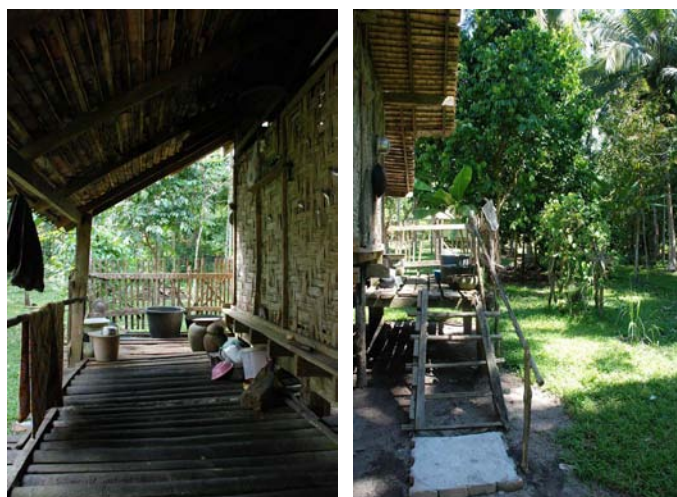
รูปที่ 3-112, 3-113 นอกชานหน้าบ้านใช้รับแขก ส่วนนอกชานหลังบ้านใช้สำหรับงานซักล้างต่างๆ เรือนนี้เป็นนอกชานเปิดโล่ง ไม่มีหลังคาคลุม มีรูปแบบเหมือนเรือนสมัยโบราณ วัสดุที่ใช้แบบดั้งเดิม คือใช้ต้นหมากทั้งต้นผ่าแบ่ง 4 ส่วน แล้วนำมาปูพื้น ซึ่งมีความทนทาน ประหยัดและสามารถทำได้ง่าย
