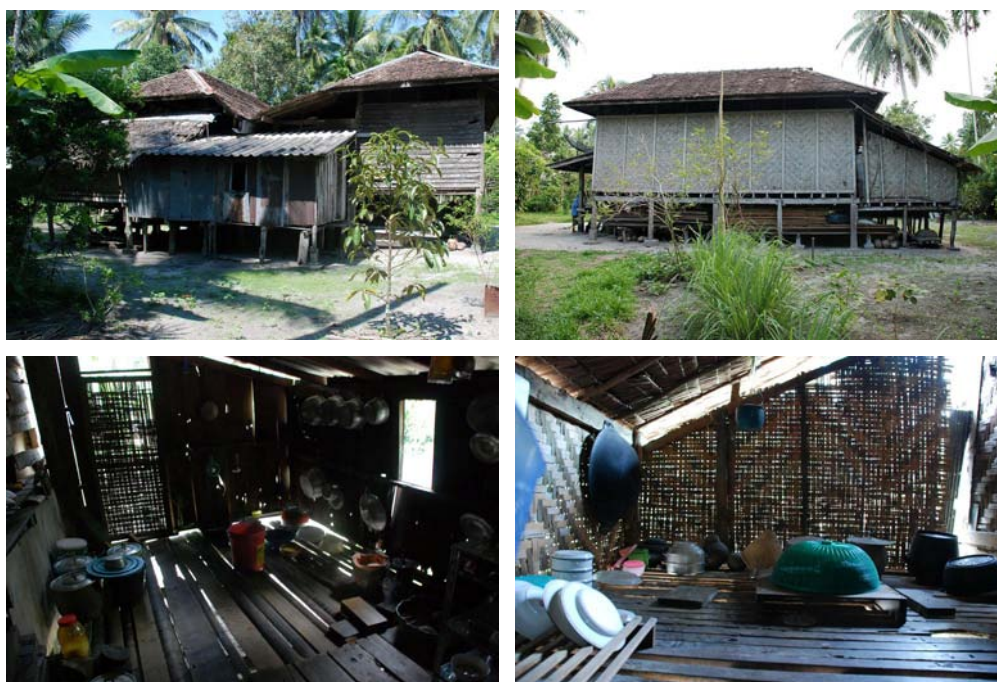
รูปที่ 3-53, 3-54, 3-55, 3-56 ห้องครัวออกสงาบจากเรือนข้าวและเรือนอาศัย ใช้ผนังไม้ไผ่สานผสมกับสังกะสีและพื้นไม้เว้นร่อง มีระดับพื้น 3 ระดับแยกพื้นที่ใช้สอย ส่วนล้าง ส่วนปรุงอาหาร และส่วนกินข้าว
