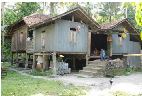
รูปที่ 3-381 แสดงการออกมุงคู่ทรงลูกข้างกีนนม และขยายชายหลังคาสองด้าน หลังคาแม่เรือนทรงหล้าทู่ห้า (ปั้นหย่า) มุขหลังคาทรงจั่ว
