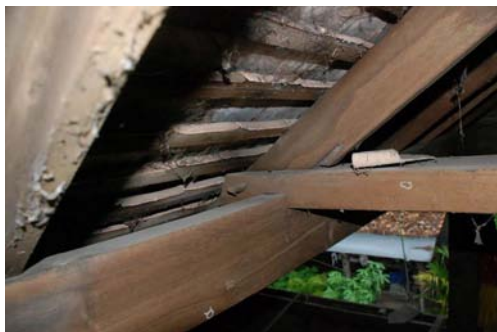
รูปที่ 3-142 ลูกสีกที่ยึดข้อกับจันทัน
