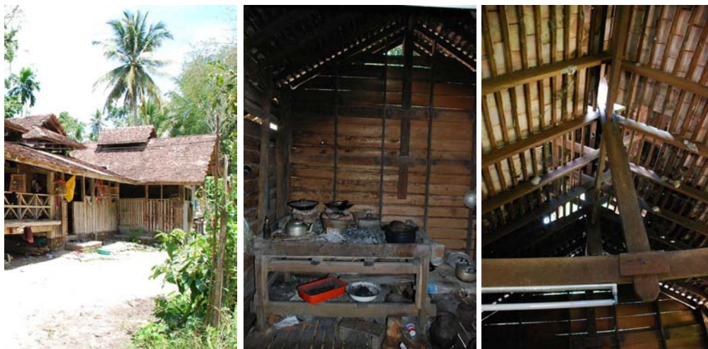
รูปที่ 3-43, 3-44, 3-45 เรือนครัว 6 แม่เสาลังคาทงจั่ว และมีหลังคาซ้อนชั้นเพื่อช่วยระบายควัน สร้างติดกับเรือนอาศัย โดยมีหลังคาและชานเป็นตัวเชื่อม ใช้ผนังไม้จริงและพื้นไม้เว้นร่อง
