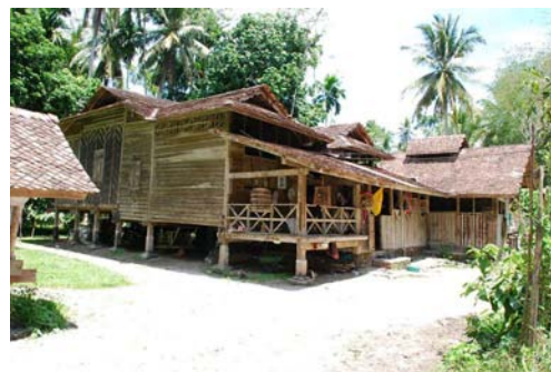
รูปที่ 3-382 แสดงการออกมุงคู่ทรงลูกข้างกีนนม และขยายชายหลังคาสองด้าน หลังคาแม่เรือนทรงหัวกะโหลกเล็ก (จั่วมะนิลา) มุขหลังคาทรงเดียวกัน
