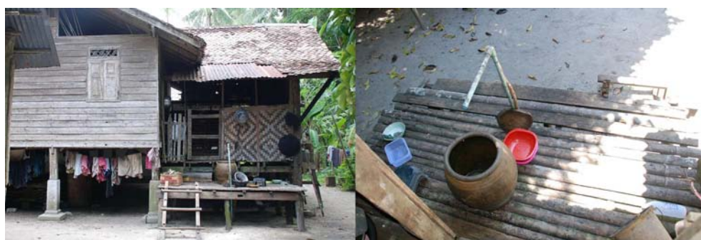
รูปที่ 3-114 นอกชานหลังบ้านในเรือนปัจจุบันนิยมใช้เครื่องสูบน้ำ จึงไม่ต้องหิ้วน้ำมาเติมเช่นสมัยโบราณ เนื่องจากเป็นพื้นที่เปิดโล่ง จึงใช้ต้นหมากผ่า 4 ส่วน เป็นวัสดุปูพื้นเช่นกัน
