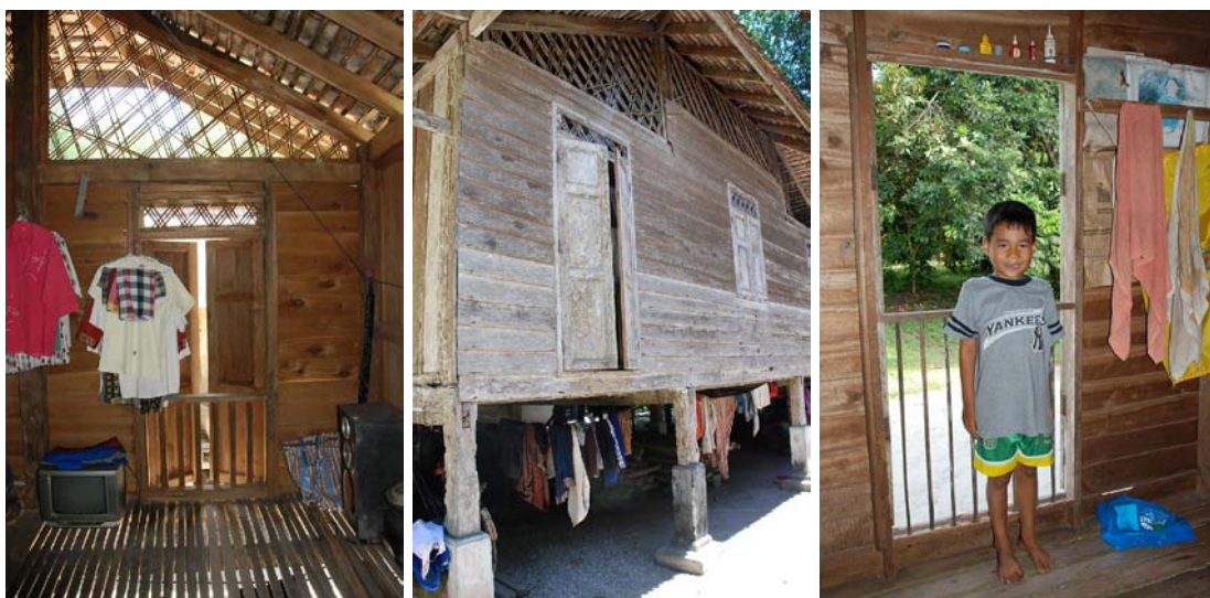
รูปที่ 4-22 แสดงการใช้บ้านหน้าต่างที่มีลักษณะเหมือนประตู เพื่อรองรับการพักผ่อนในอริยาบท ของการนอน หรือนั่ง ซึ่งนอกจากจะสามารถนำลมเข้ามาให้เกิดความสบายแล้ว ยังเปิดทัศนวิสัย การมองเห็นของผู้ที่ใช้งานอีกด้วย บ้านหน้าต่างลักษณะนี้ส่วนมากจะใช้ในบริเวณพยาบาลผู้ป่วย ซึ่งจะต้องนอนอยู่ตลอดเวลา
