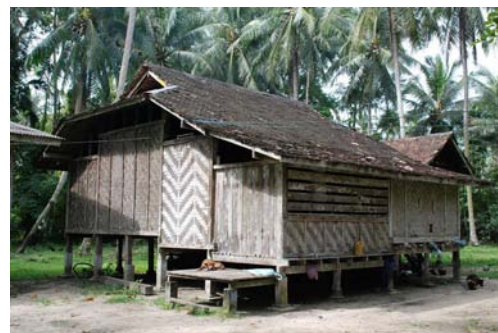
รูปที่ 3-378 แสดงการขยายชายหลังคาสองด้าน หลังคาแม่เรือนทรงหัวกะโหลเล็ก (จั่วมะนิลา)
