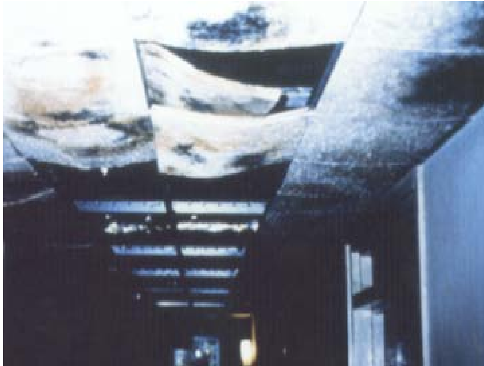
ภาพที่ 4-5 แสดงการเกิดการควบแน่นเป็นหยดน้ำ (ส่วนงานฝ้าเพดาน)
