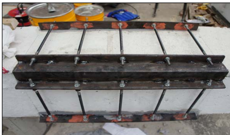
ภาพที่ 3.9 การติดตั้งกรงเหล็กเสริมโดยใช้กาวอีพอกซี
