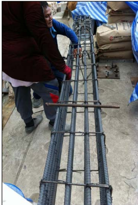
ภาพที่ 3.4 การประกอบเหล็กเสริมตามยาวและเหล็กเสริมตามขวางของตัวอย่างทดสอบ
