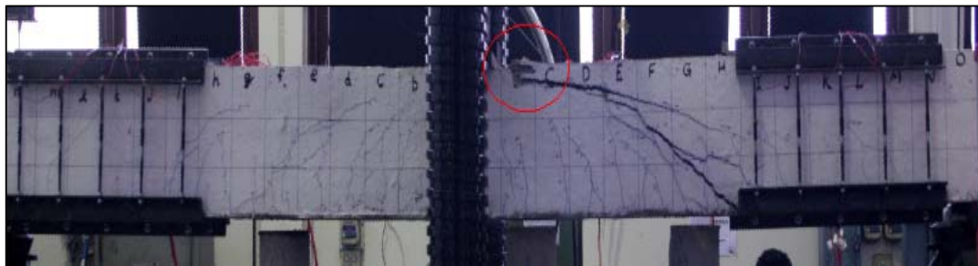
(จ) เกิดการหลุดร่อนและแตกออกเป็นก้อนของคอนกรีตบริเวณรอยแตกร้าวลักษณะเป็นเส้นทแยงขนาดใหญ่ที่ระยะการเคลื่อนที่เท่ากับ 28 มม.
