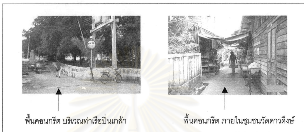
ภาพที่ 4-39 พื้นคอนกรีต บริเวณท่าเรือ
