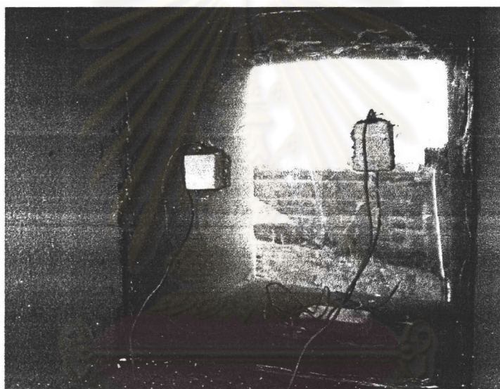
รูปที่ 3.18 แสดงการติดตั้งแผ่นสแตนเลสผนังด้านใน เพื่อกันความชื้น
