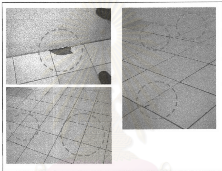
แผนภาพที่ 6.2 แสดงสภาพทรุดโทรมของวัสดุปูพื้นภายในศูนย์การค้าเซ็นทรัลพลาซาพระราม 3
