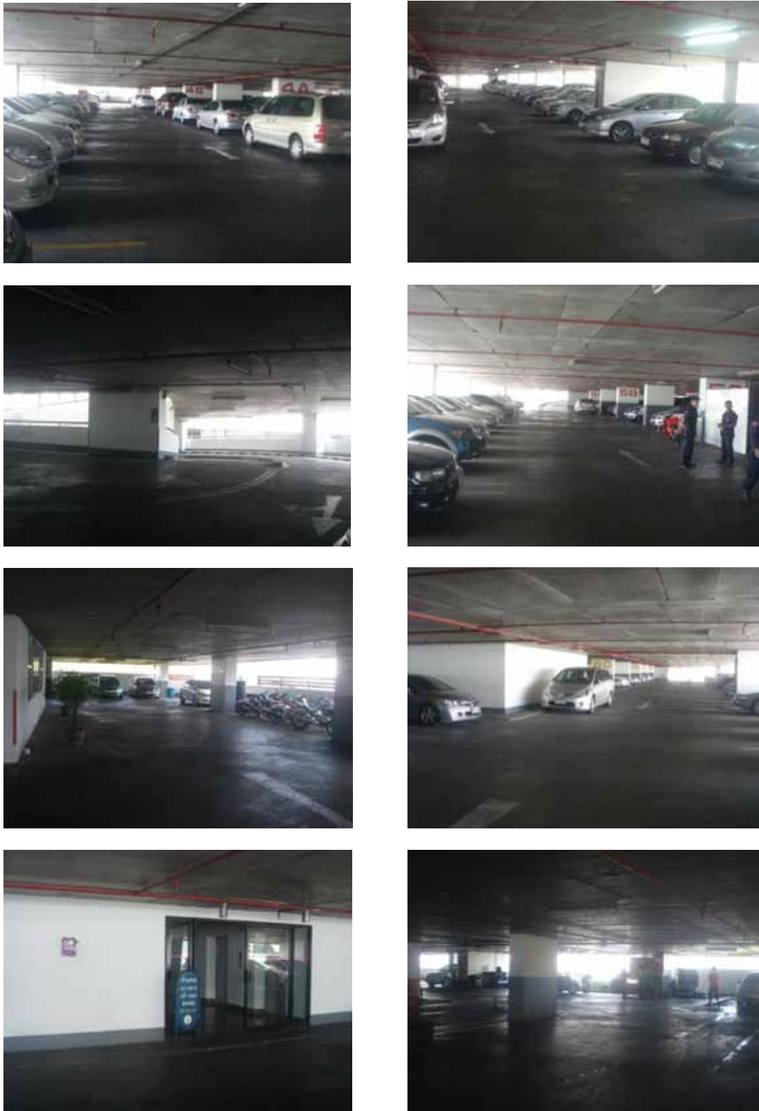
รูปที่ 4-41 สภาพที่จอดรถยนต์ในปัจจุบันอาคารขนาดใหญ่พิเศษ E (1)
