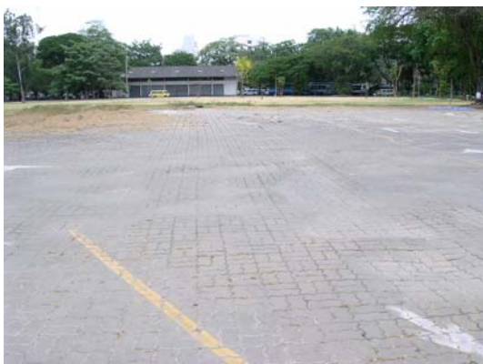
ภาพที่ 3.8 แสดงบริเวณลานคอนกรีต(1)
