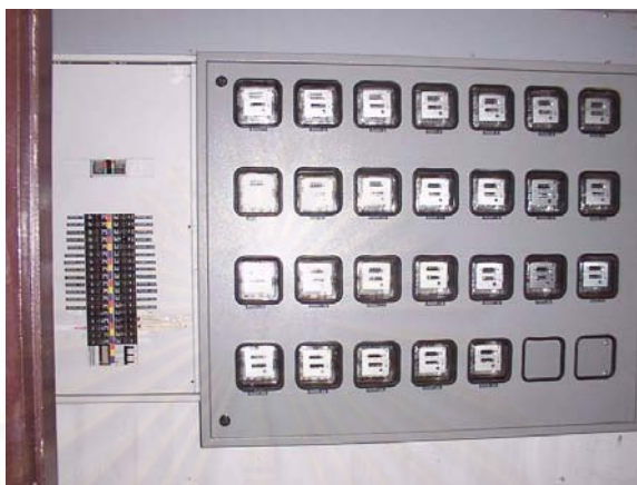
รูปที่ 4.41 แสดงมิเตอร์ไฟฟ้าสำหรับส่วนห้องพักภายในอาคารสว่างคนิเวศ
