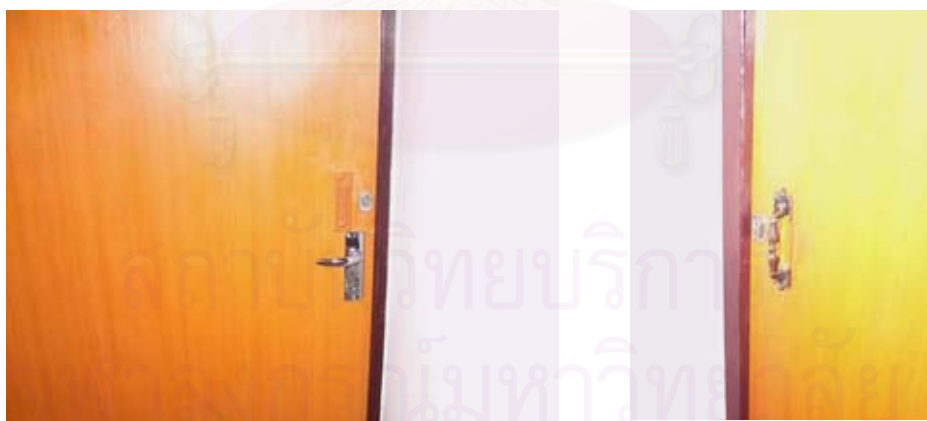
รูปที่ 5.35 แสดงมือจับประตูที่ผู้สูงอายุติดเพิ่มเติม
