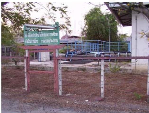
รูปที่ 4.12 แสดงบ่อบำบัดน้ำเสียรวมของสถานพักฟื้นสวางคนิวาส
