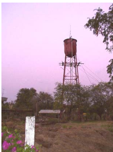
รูปที่ 4.11 แสดงถังเก็บน้ำของสถานพักฟื้นสวางคนิวาส
