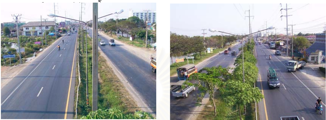
รูปที่ 4.3 แสดงถนนสุขุมวิทหน้าสถานพักฟื้นสววงคินิวาส
