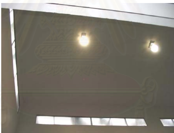
รูปที่ 4.42 แสดงการใช้ไฟฟ้าส่วนกลางบริเวณโถง ภายในอาคาร
