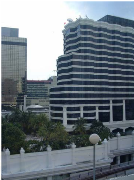
รูปที่ 3.1 แสดงตัวอาคารโรงแรมแกรนด์ไฮแอท เอราวัณ
