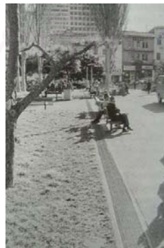
รูปที่ 6.13 แสดงช่องท่อรางน้ำ (Channel drain หรือ Strip drain) และการวางแนวท่อระดับเดียวกับพื้นลาดแข็ง (Theodore Osmundson, 1999)
