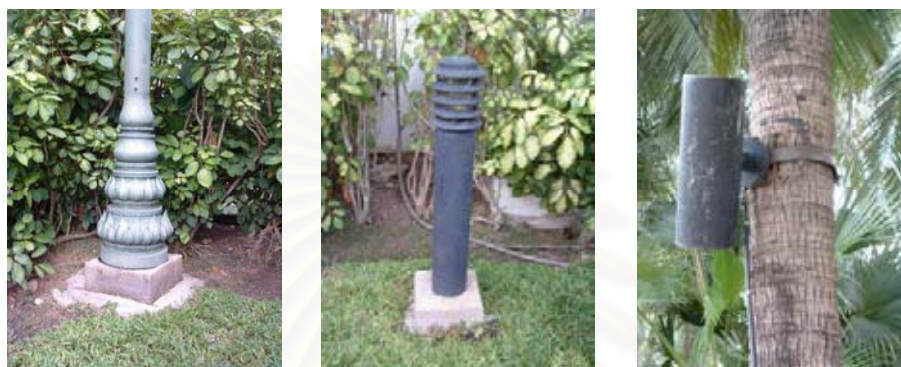
รูปที่ 3.16 แสดงการยึดเสาไฟส่องสว่างของเสาระดับสูง ระดับกลาง และไฟยึดที่ลำต้นมะพร้าว (จากรูปซ้ายมาขวาตามลำดับ)
