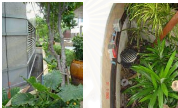
รูปที่ 3.58 แสดงช่องว่างจากการแยกผนังอาคารสูงกับผนังหลุมปลูกออกจากกันและทำเป็นรางน้ำ (รูปซ้าย)
