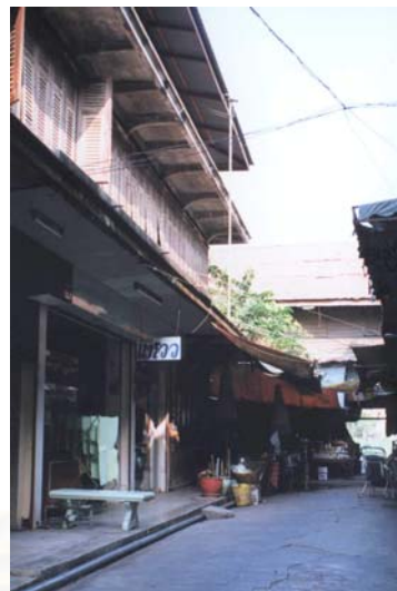
ภาพที่ 3.66 มุมมองบ้านขุนจ้านงค์จากถนนเลียบบนที่
