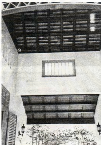
ภาพที่ 2.12 การใช้เครื่องไม้เดิมภายในอาคารในส่วนของหลังคา (ซ้าย)
