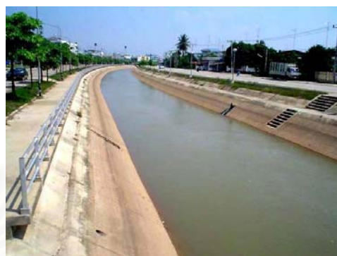
ภาพที่ 5.7 สภาพเดิมของริมฝั่งคลองส่งน้ำในพื้นที่ (ซ้าย)
