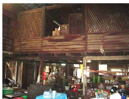
ภาพที่ 4.20 สภาพภายในพื้นที่ก่อนการปรับปรุง (ขวา)
