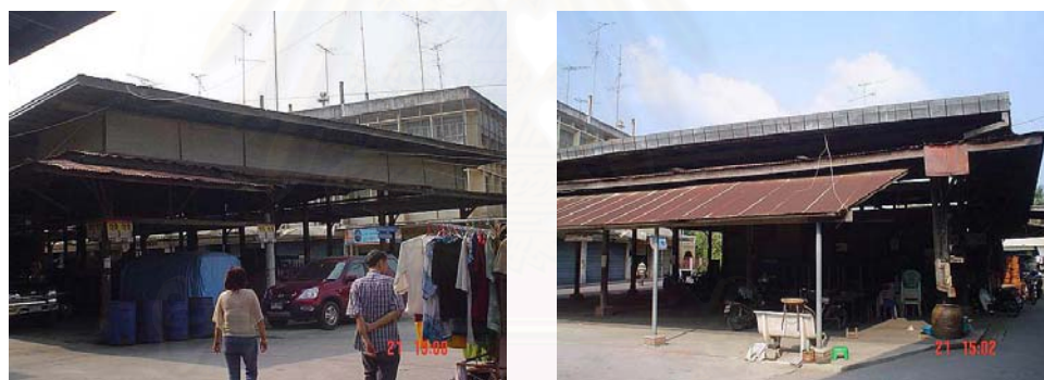
ภาพที่ 3.35 ตลาดสด กรณีศึกษา ข (ซ้าย-มุมมองจากด้านแม่น้ำ,ขวา-มุมมองจากถนนมิตรสัมพันธ์ ตามลำดับ) ที่มา : ภาพถ่ายจากการสำรวจพื้นที่
