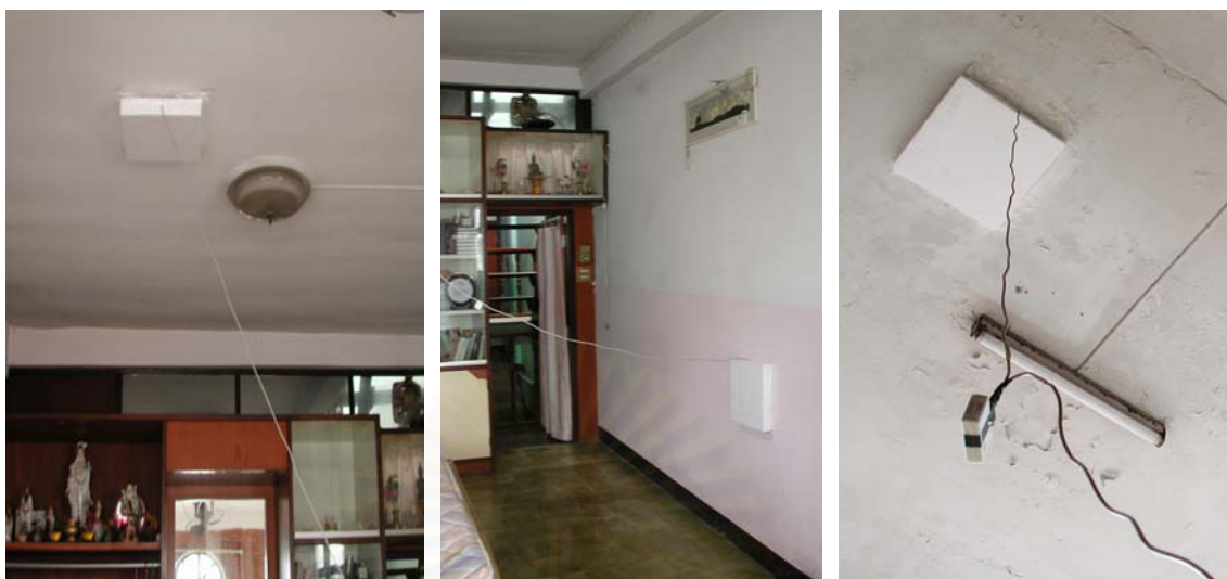
ภาพที่ 3-06 การติดตั้งหัวเซ็นเซอร์วัดอุณหภูมิผิววัสดุ
