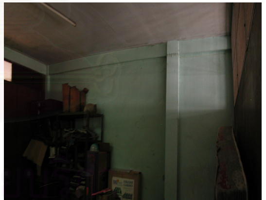
โถงบันได B4
