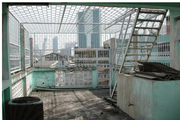
พื้นดาดฟ้า-ถึงสำรอน้ำ
