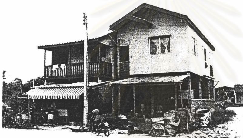
ภาพที่ 11 แสดงการก่อสร้างบ้านในช่วงแรกที่ขาดการควบคุม
