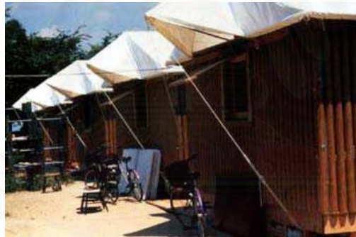
ภาพที่ 20 : ภาพแสดงอาคารพักอาศัยชั่วคราว เมืองโกเบ ที่ก่อสร้างด้วยท่อกระดาษ (ที่มา: http://www.city.kobe.jp/cityoffice )
