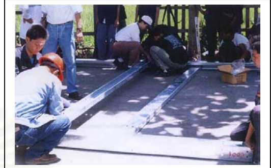
ภาพที่ 28 : ภาพแสดงการวัดระยะ ตั้งฉากในการติดตั้งชิ้นส่วนโครงสร้างแผงแรกของอาคาร
