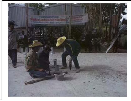
ภาพที่ 30 : ภาพแสดงการปรับปรุงตำแหน่งของเสา และการติดตั้งฐานเสาในตำแหน่งใหม่
