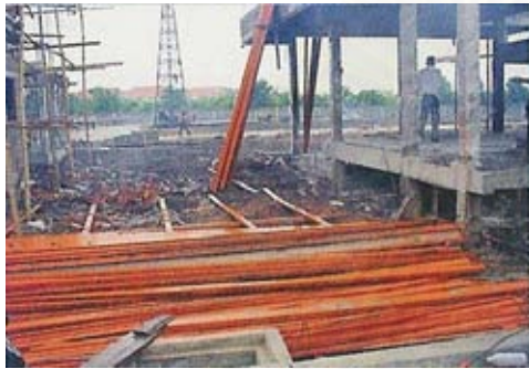
ภาพที่ 77 : ภาพแสดงการทาสีกันสนิมบนชิ้นส่วนโครงสร้าง และการเชื่อมติดตั้งชิ้นส่วนโครงสร้างเหล็กในระบบทั่วไป
