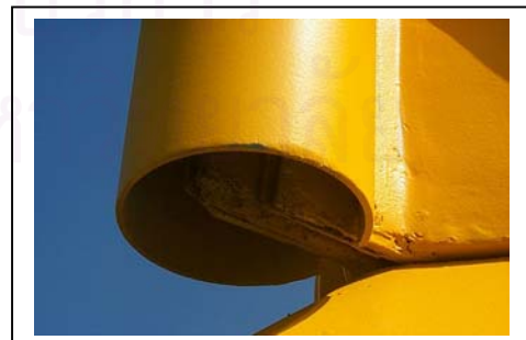
ภาพที่ 37 : ภาพแสดงจุดเชื่อมต่อ และครอบมุมบริเวณจุดเชื่อมต่อของอาคาร (ซ้าย)
