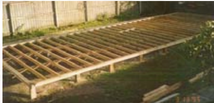
ภาพที่ 42 : ภาพแสดงโครงสร้างพื้นอาคารพักอาศัยสำเร็จรูป ในประเทศ New Zealand
