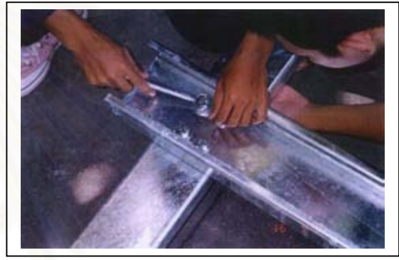
ภาพที่ 31 : ภาพแสดงการชิ้นส่วนที่มีหลายขนาด และการติดตั้งชิ้นส่วนด้วยการขันน็อตติด
