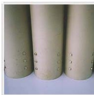
ภาพที่ 21 : ภาพแสดงตัวอย่างการเชื่อมต่อชิ้นส่วนท่อกระดาษของอาคารพักอาศัยชั่วคราว (ที่มา: http://www.city.kobe.jp/cityoffice )
