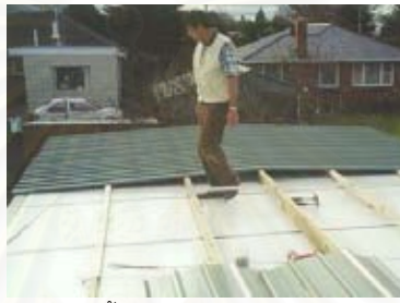
ภาพที่ 45 : ภาพแสดงการติดตั้งแผ่นวัสดุมุงหลังคาโลหะบนโครงสร้างไม้เหนือแผ่นฝ้าเพดาน
