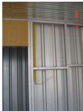
ภาพที่ 106 : ภาพแสดงตัวอย่างการบุผิวผนังด้วยแผ่นโลหะรีดลอน และไม้อัด ปิดทับแนวเดินท่อในผนัง และฝ้าเพดาน
