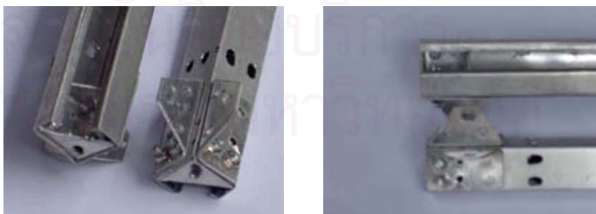
ภาพที่ 96 : ภาพแสดงการติดตั้งข้อต่อ และอุปกรณ์ยึดติดบนโครงสร้างเสาอาคาร
