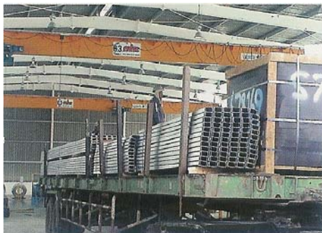
ภาพที่ 91 : ภาพแสดงการขนส่งชิ้นส่วนขึ้นรถด้วยเครน และการผูกมัดชิ้นส่วนบนรถบรรทุก
