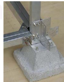
ภาพที่ 99 : ภาพแสดงการติดตั้งคานหลักของอาคาร ยึดติดกับตอม่อบนฐานราก
