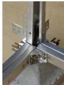
ภาพที่ 99 : ภาพแสดงการติดตั้งคานหลักของอาคาร ยึดติดกับตอม่อบนฐานราก
