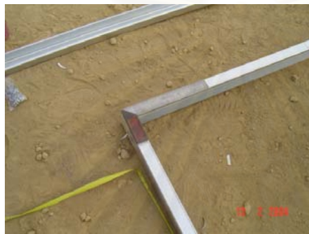
ภาพที่ 93 : ภาพแสดงการวัดระยะมุมฉากบน และการติดตั้งโครงหลักของชิ้นส่วนอาคาร
