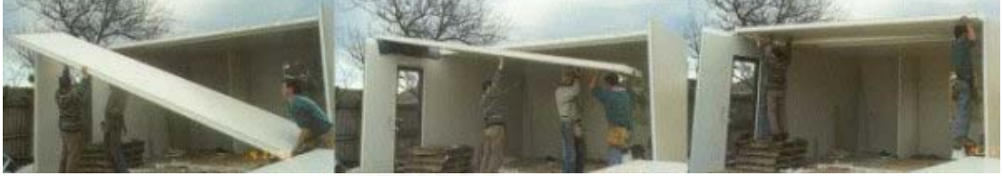
ภาพที่ 44 : ภาพแสดงการติดตั้งแผ่นวัสดุฝ้าเพดานของอาคารสำเร็จรูป
