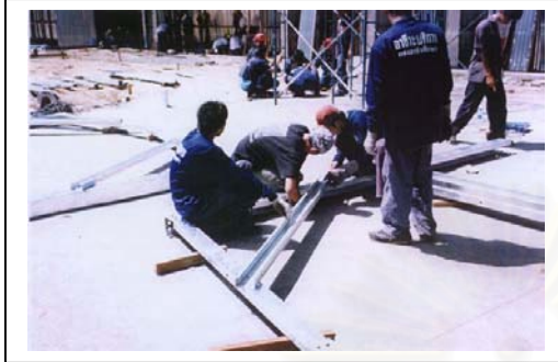
ภาพที่ 28 : ภาพแสดงการวัดระยะ ตั้งฉากในการติดตั้งชิ้นส่วนโครงสร้างแผงแรกของอาคาร
