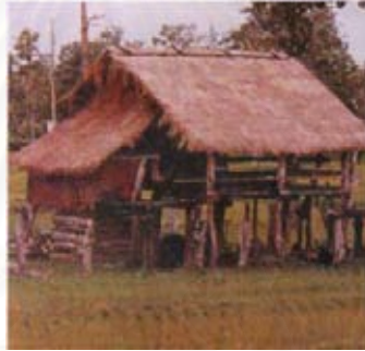
ภาพที่ 5 : ภาพแสดงตัวอย่างเรือนเครื่องผูกของไทย
