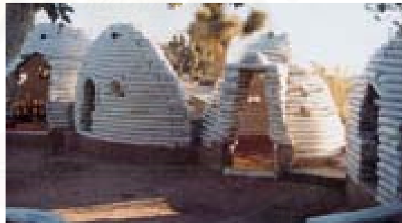
ภาพที่ 18 : ภาพแสดงอาคารพักอาศัยชั่วคราวระบบ Super-Adobe ที่ก่อสร้างในประเทศ Senegal
