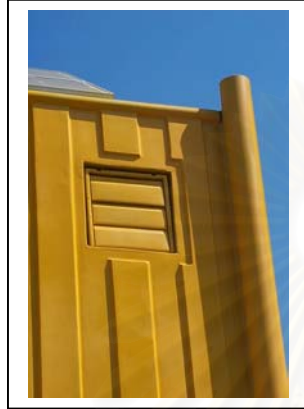
ภาพที่ 40 : ภาพแสดงช่องระบายอากาศ และหน้าต่างที่หล่อ และติดตั้งสำเร็จไว้บนชิ้นส่วน
