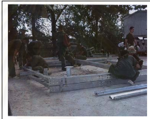
ภาพที่ 29 : ภาพแสดงการใช้โครงสร้างแผงแรกเป็นแบบในการติดตั้งโครงสร้างแผงต่อไป
