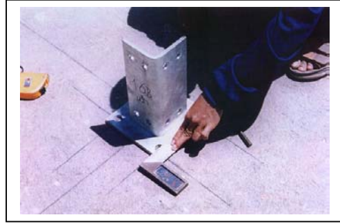
ภาพที่ 30 : ภาพแสดงการปรับปรุงตำแหน่งของเสา และการติดตั้งฐานเสาในตำแหน่งใหม่
