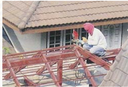
ภาพที่ 77 : ภาพแสดงการทาสีกันสนิมบนชิ้นส่วนโครงสร้าง และการเชื่อมติดตั้งชิ้นส่วนโครงสร้างเหล็กในระบบทั่วไป
