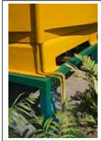
ภาพที่ 38 : ภาพแสดงการรั่วท่อสายไฟ และประปาในส่วนครอบมุมไฟเบอร์กลาส
