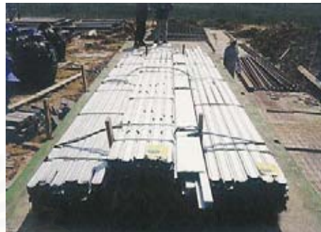
ภาพที่ 91 : ภาพแสดงการขนส่งชิ้นส่วนขึ้นรถด้วยเครน และการผูกมัดชิ้นส่วนบนรถบรรทุก
