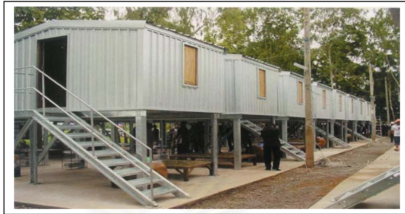
ภาพที่ 25 : ภาพแสดงอาคารพักอาศัยในโครงการอาคารฉุกเฉิน ต.น้ำก้อ จ.เพชรบูรณ์
