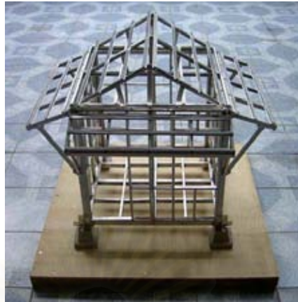
ภาพที่ 107 : ภาพแสดงการติดตั้งค้ำยัน และหลังคาปีกนก
