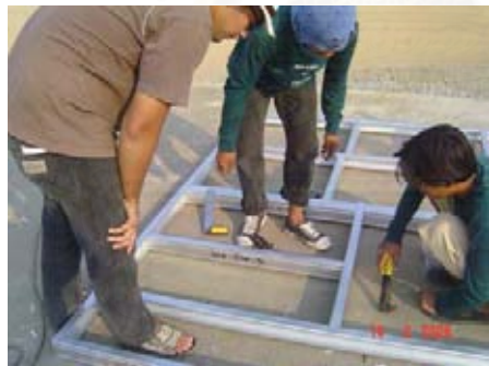
ภาพที่ 94 : ภาพแสดงการติดตั้งโครงขอยของชิ้นส่วนอาคาร ที่มีการ Lock กันแบบมุมฉาก
