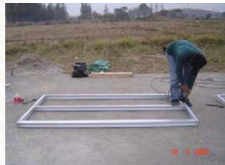
ภาพที่ 93 : ภาพแสดงการวัดระยะมุมฉากบน และการติดตั้งโครงหลักของชิ้นส่วนอาคาร
