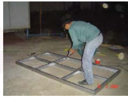
ภาพที่ 94 : ภาพแสดงการติดตั้งโครงขอยของชิ้นส่วนอาคาร ที่มีการ Lock กันแบบมุมฉาก
