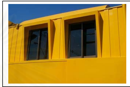
ภาพที่ 40 : ภาพแสดงช่องระบายอากาศ และหน้าต่างที่หล่อ และติดตั้งสำเร็จไว้บนชิ้นส่วน
