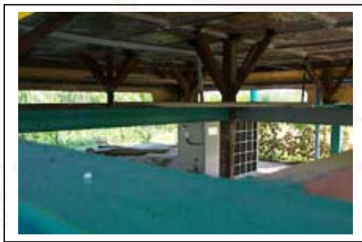
ภาพที่ 39 : ภาพแสดงโครงสร้างเหล็กที่สร้างเพิ่มเติมเพื่อรับแรงที่ถ่ายเทจากพื้นห้อง
