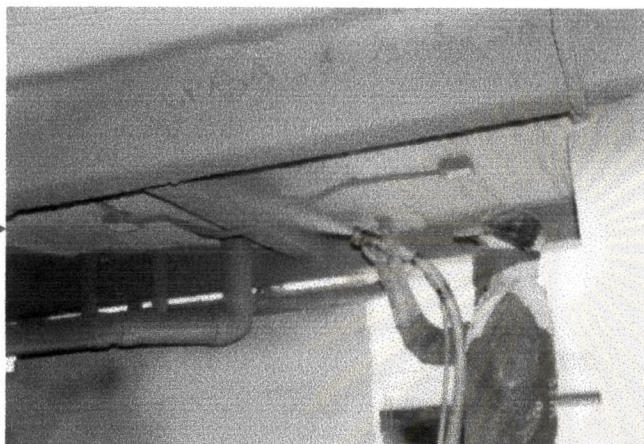
ภาพที่ 5-21 การใช้สารพ่นหุ้มกันไฟให้กับโครงสร้างเหล็ก
