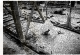
ภาพที่ 5-9 โครงสร้างส่วนหัวเสาเหล็กรูปพรรณที่ทำการเทคอนกรีตกรอกลงไปแล้ว
