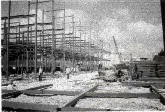
ภาพที่ 5-7 แสดงการติดตั้งเฟรมโครงสร้างเหล็กด้วย Mobile Crane
