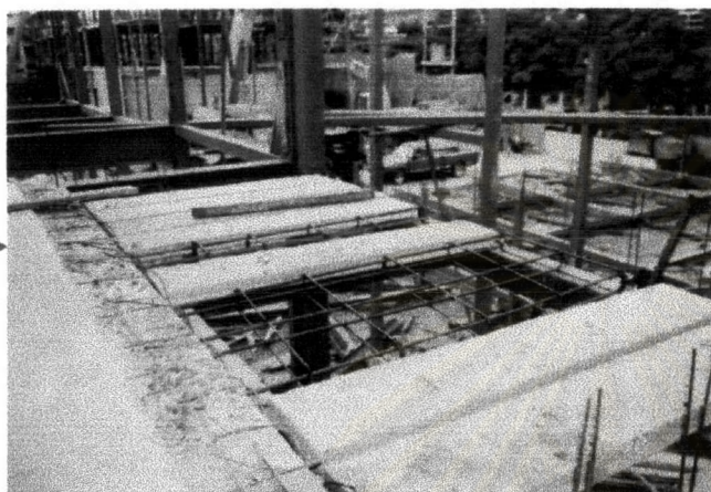
ภาพที่ 5-17 การใช้พื้นคอนกรีตสำเร็จรูปในส่วนห้องน้ำหอพัก
