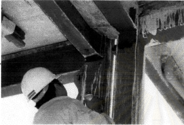
ภาพที่ 5-19 การพ่นสเปรย์น้ำยาเพื่อทดสอบคุณภาพของรอยต่อโครงสร้าง
