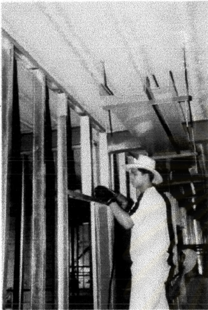
ภาพที่ 5-15 แสดงการติดตั้งโครงคร่าวเหล็กชุบสังกะสีสำหรับผนังภายใน
