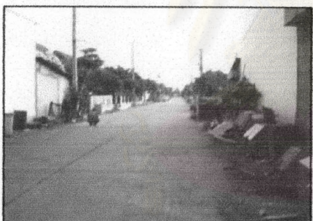
109. ซอยย่อย ม.จันทิมาซอยข้างโรงกลึง (06G)
