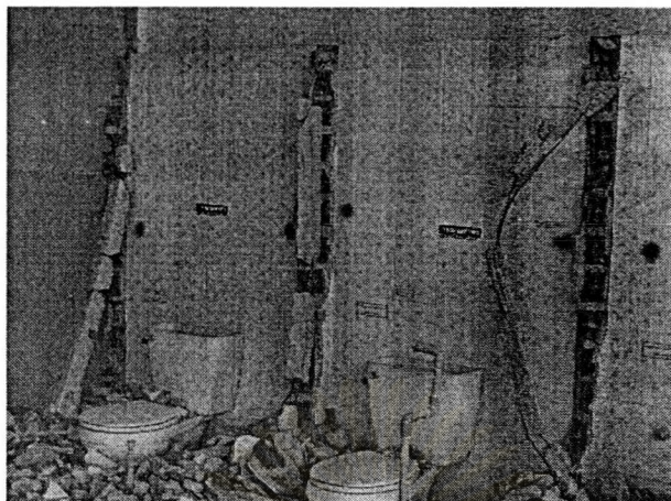
รูปที่ 3.25 แสดงเศษคอนกรีตที่เกิดจากการรื้อทุบเสาเอ็นและคานทับหลัง ค.ส.ล.
