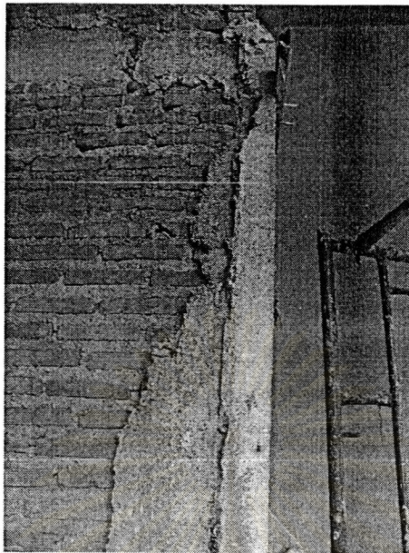
รูปที่ 3.14 แสดงการล้าเมื่อยของเสาเอ็น ค.ส.ล. อันเนื่องมาจากการเข้าแบบไม่ได้ดัง
