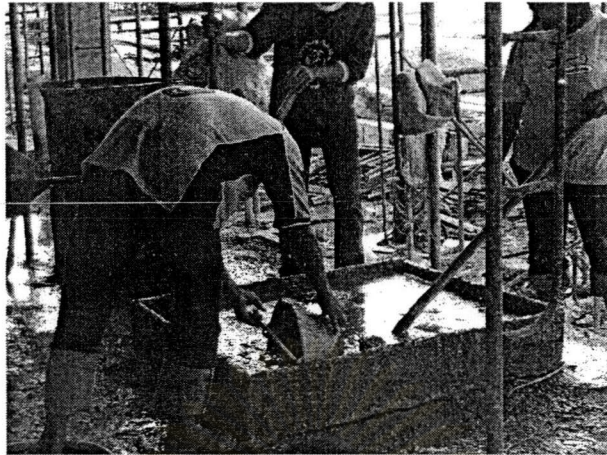
รูปที่ 3.6 แสดงคอนกรีตที่ผสมสำหรับเทหล่อเสาเอ็นและคานทับหลัง ค.ส.ล.
