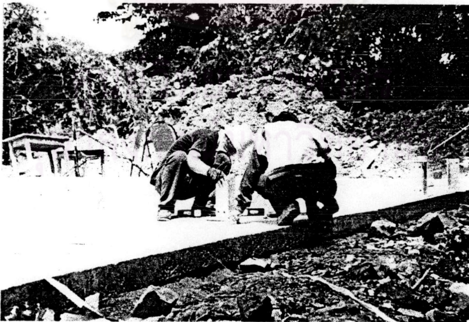
ภาพที่ 5-6 นำ Plate ฐานเส้ามาวัดระยะให้ลงตามตำแหน่ง หาแนวและฉากก่อนการยึดกับทุกเหล็ก
