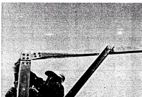
ภาพที่ 5-47 แสดงการยึดเหล็กประกบยึดด้าน รูปด้านซ้ายประกอบถูก และรูปด้านขวาประกอบผิด
