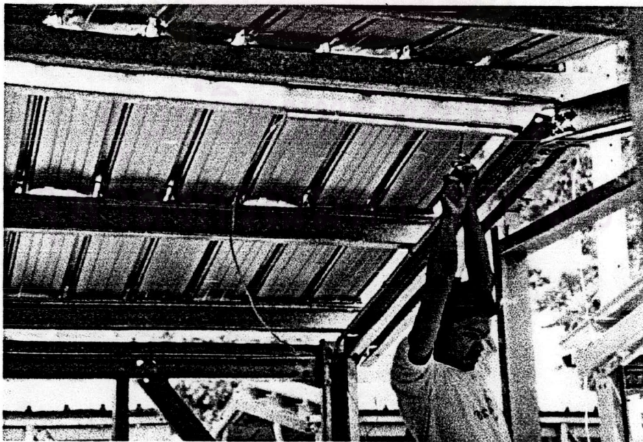
ภาพที่ 5-36 เดินสายไฟในท่อPVC. ชั้นบน
