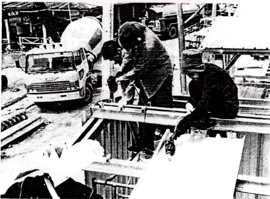
ภาพที่ 5-15 การยึดขาล็อคเข้ากับแปรับหลังคา
