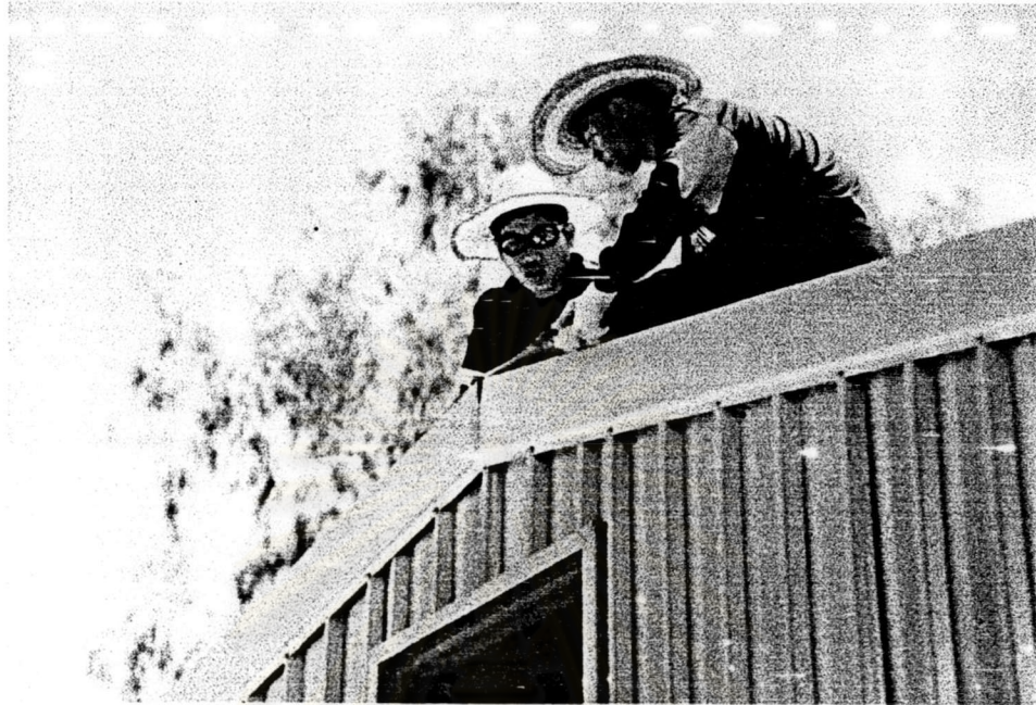
ภาพที่ 5-25 ประกอบกรอบจั่วบนสันหลังคา
