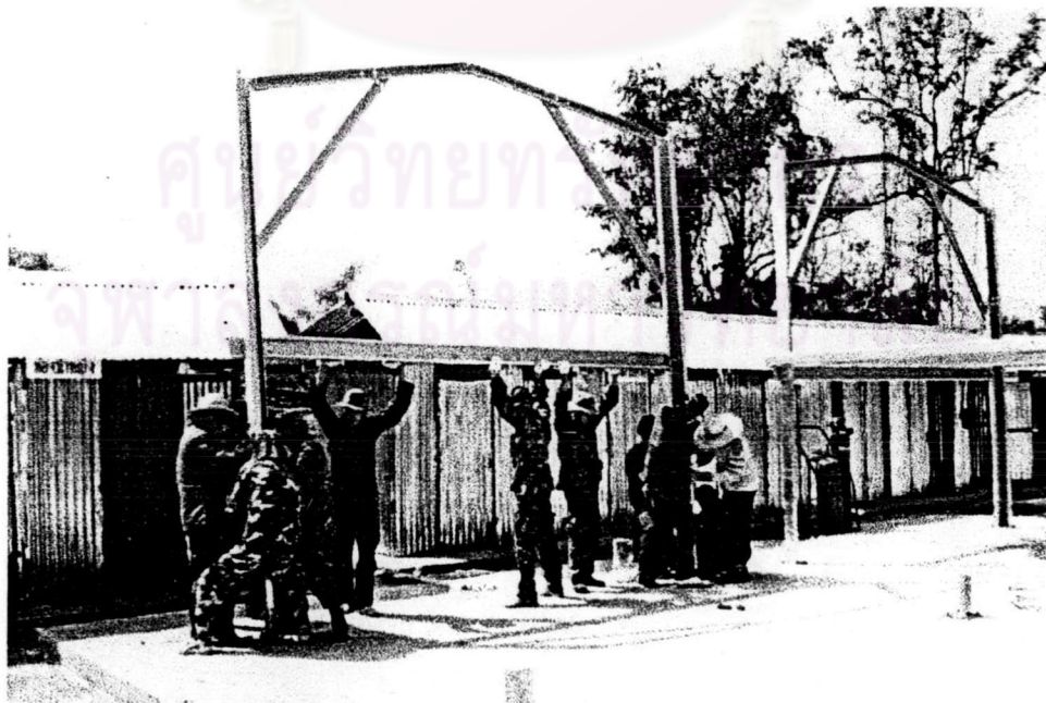
ภาพที่ 5-9 แสดงการยกชิ้นส่วนโครง1ชุดมาประกอบบนPlateฐานเสา ซึ่งใช้คน 6-8 คนในการยกประกอบ
