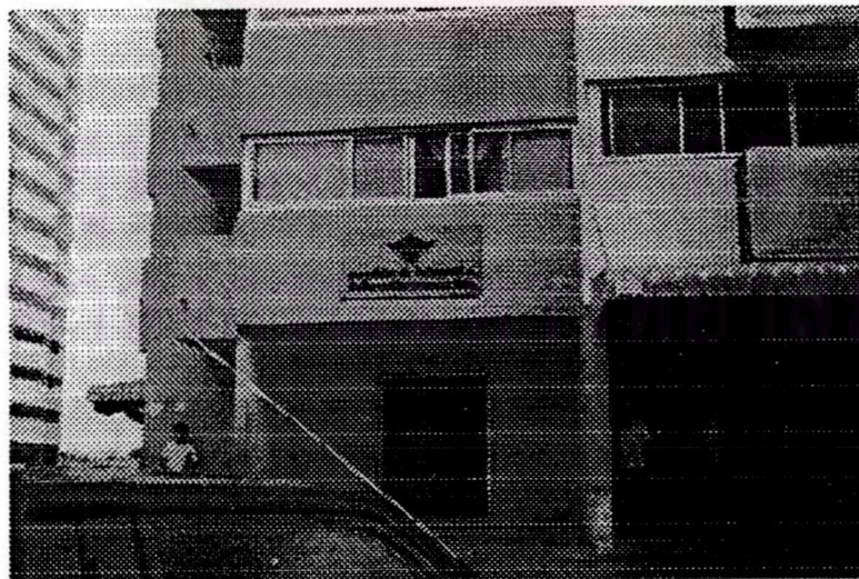
ภาพที่ 2 แสดงตึกที่พักข้าราชการกระทรวงกลาโหม ในโครงการเมืองทองธานี แจ้งวัฒนะ
