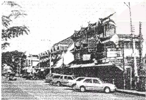
5.23 กลุ่มอาคารตึกแถวมีคุณลักษณะเช่นเดียวกับภาพด้านบน สำหรับ ย่านนี้เป็นย่านธุรกิจการขายไม้ดอกไม้ประดับแต่เดิมมา ภายหลังได้รับการโยกย้ายให้ไปยังพื้นที่อื่นๆทำให้บรรดาตึกแถวที่สร้างขึ้นมาริเวณนี้ ถูกปล่อยทิ้งร้างไว้มากส่วน
