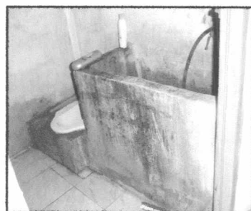
สภาพภายในห้องน้ำ
