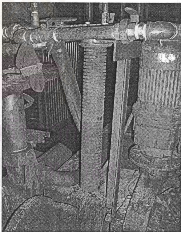
การถอดชุดกรองดักฟองอากาศ
