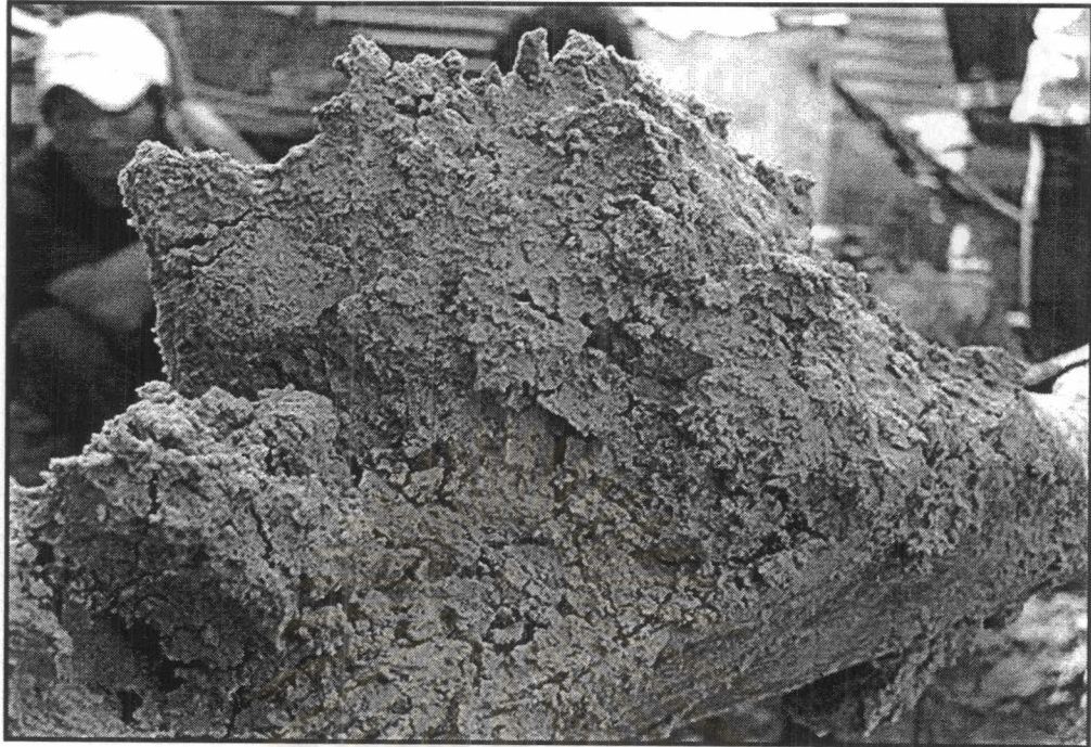
รูปที่ ข.5 สภาพของดินซีเมนต์หลังจากทำเจ็ทเกร้าตั้งเป็นเวลา 1 คืน
