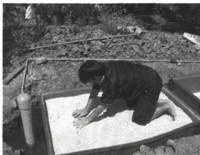
รูปที่ 3.12 การเททรายเม็ดเล็กปิดทับชั้นกรวด
