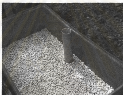
รูปที่ 3.10 การเทกรวดขนาดใหญ่ปิดทับเส้นท่อ
