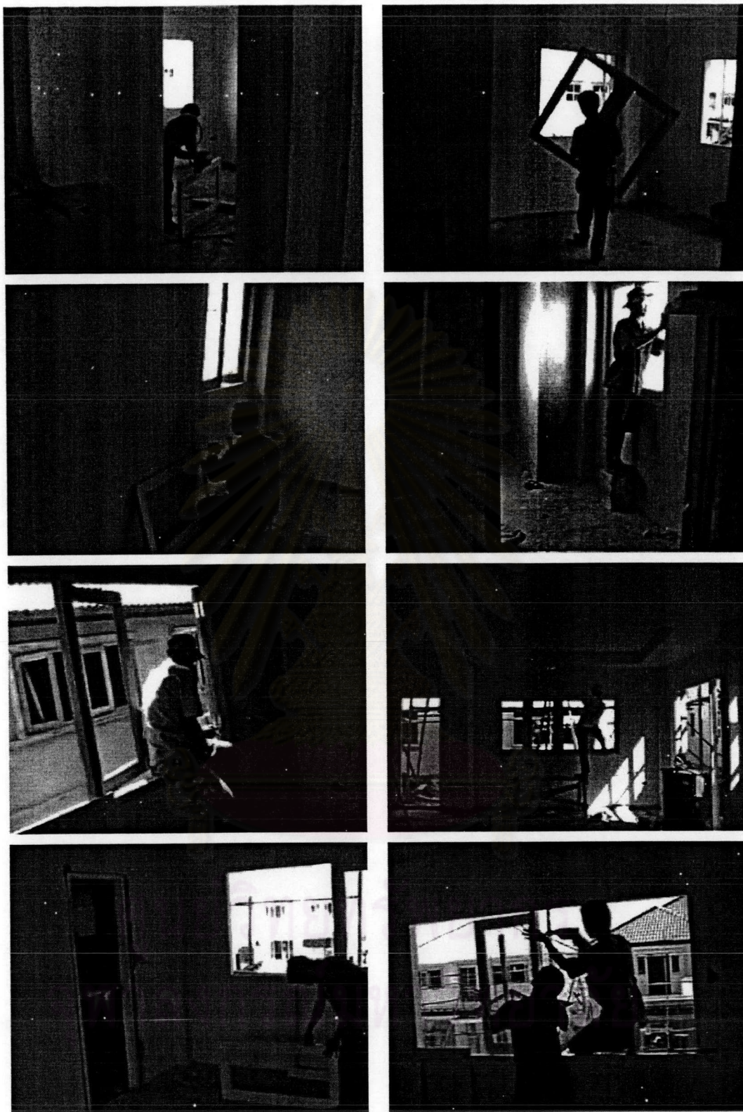
รูปที่ ผ.6 งานติดตั้งบานหน้าต่าง
