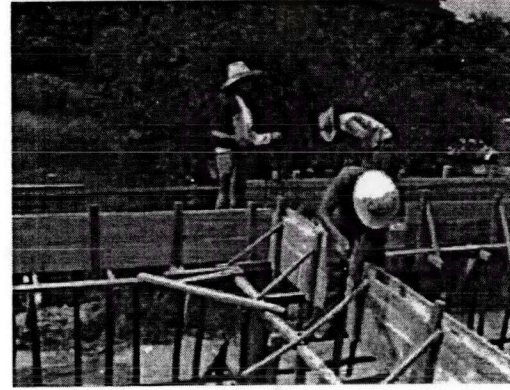
รูปที่ ผ.3 งานไม้แบบ
