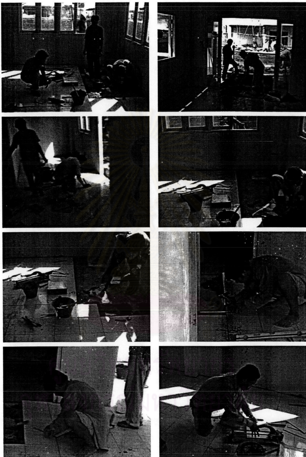
รูปที่ ผ.7 งานปูกระเบื้องพื้นขนาด 12X12 นิ้ว
