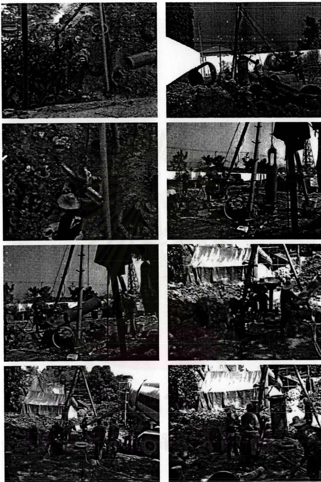
รูปที่ ผ.2 งานเสาเข็มเจาะเส้นผ่าศูนย์กลาง 0.60 ม.
