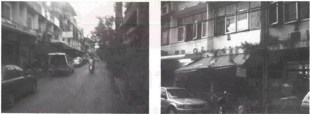
ภาพที่ 4.7 แสดงอาคารพาณิชย์ บริเวณ หลัง โรงแรมเอเชีย ราชเทวี
