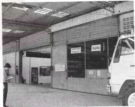
รูปที่ 5.17-5.18 อาคารโรงงานขนาดกลางกลาง โครงสร้างเหล็ก สร้างอาคารเชื่อมต่อกันหลายหลังมีการแยกส่วนไวไฟออกจากส่วนผลิต
