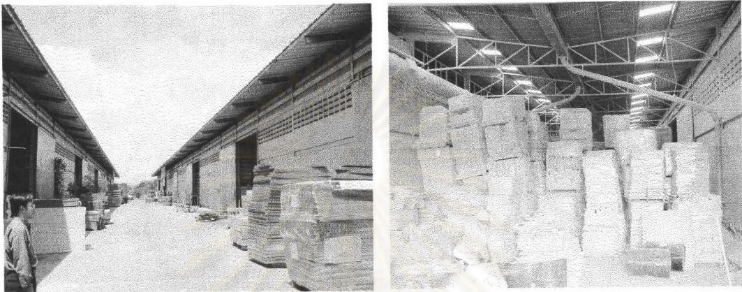
รูปที่ 5.1 และ 5.2 แสดงตัวอย่างอาคารโรงงานขนาดใหญ่ ที่เป็นกลุ่มอาคารชั้นเดียว พื้นที่เชื่อมต่อระหว่างอาคารใช้ในการเก็บวัตถุดิบและสินค้า
