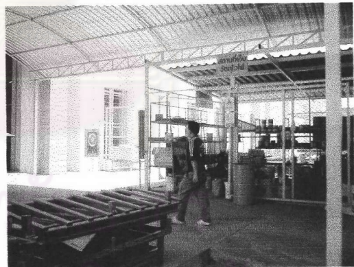
รูปที่ 5.8 การแยกเก็บสารไวไฟไว้ห่างจากกระบวนการผลิต
