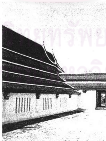
รูปที่ 4.4.12 ผนังด้านข้างทิศเหนือและทิศใต้เป็นผนังที่เจาะช่องทำเป็นช่องสำหรับการ
