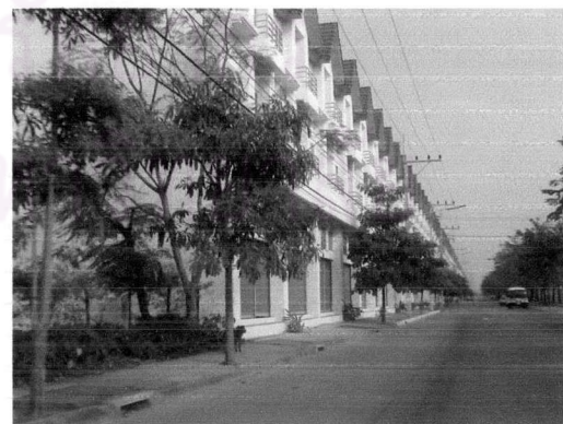
อาคารพาณิชย์ด้านหน้าเพิ่งก่อสร้างใหม่
