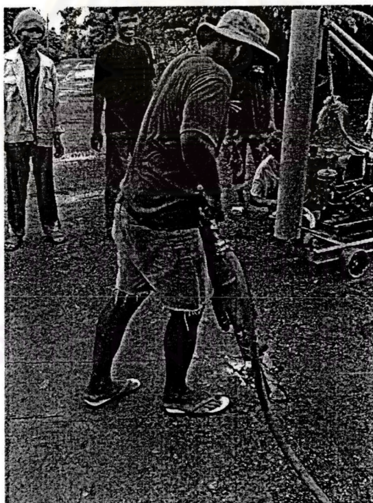
รูปที่ 5.2 แสดงขั้นตอนการใช้เครื่องตัดคอนกรีตเซาะร่องแนวลึก 2 นิ้ว
