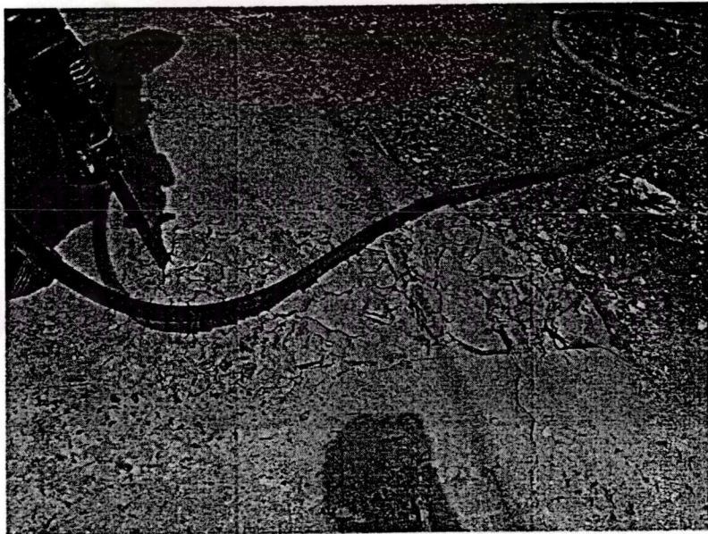
รูปที่ 5.9 แสดงลักษณะการแตกของผิวถนนคอนกรีตที่ทำลายด้วยเครื่องเจาะคอนกรีตชนิดอาศัยแรงกระแทกจากแรงอัดอากาศ
