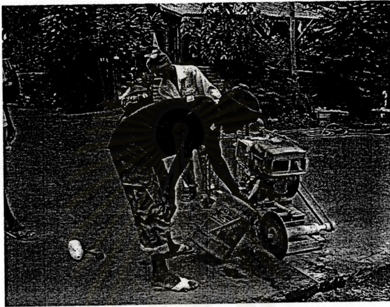
รูปที่ 3.10 แสดงขั้นตอนการใช้เครื่องตัดคอนกรีตเพื่อเจาะแนวร่องลึก 1 – 2 นิ้ว เพื่อกำหนดขอบเขตการทำลาย
