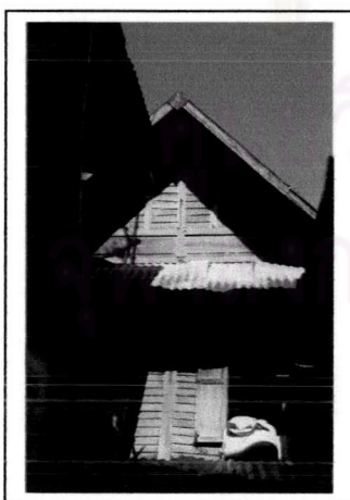
ภาพที่ 5.13-14 แสดงความชันของหลังคาที่เป็นเอกลักษณ์ของเรือนไท-โคราชที่มา ภาพโดยนายธีรชัย ลีสุระพลานนท์ ธันวาคม 2546
