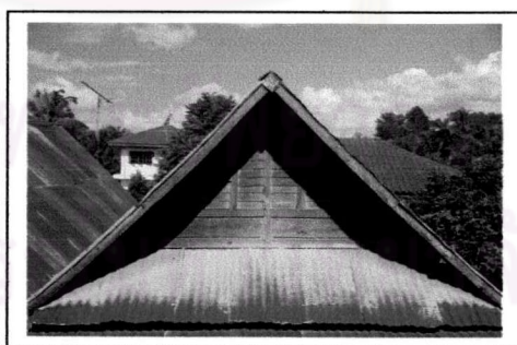
ภาพที่ 5.13-14 แสดงความชันของหลังคาที่เป็นเอกลักษณ์ของเรือนไท-โคราชที่มา ภาพโดยนายธีรชัย ลีสุระพลานนท์ ธันวาคม 2546
