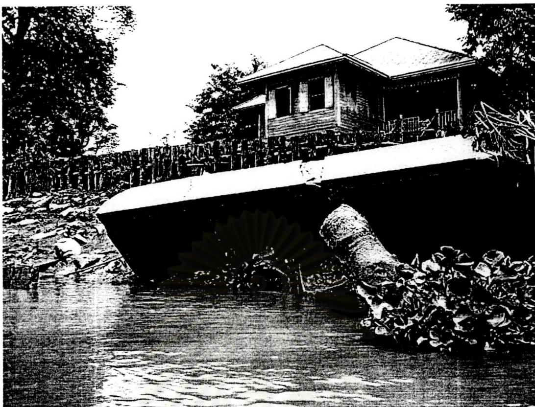
รูปที่ 4.19 รูปแสดงตลิ่งหน้าจวนผู้ว่าราชการจะเชิงเทราที่พังทลายหลังการทดลอง ปิดประตูระบายน้ำวันที่ 6 มกราคม 2543
