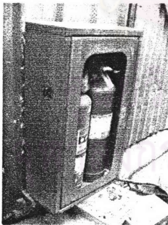
ภาพที่ 5.33 ติดตั้งถังดับเพลิงภาพที่ เป็นระยะในชุมชน
