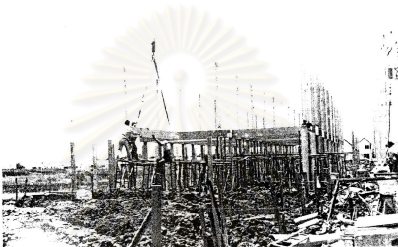
ภาพ 4.14 การติดตั้งคานขึ้นส่วนสำเร็จ
