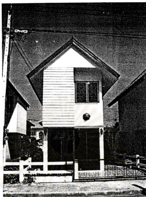
ภาพ 4.19 ตัวอย่างการต่อเติมแบบใช้ลุมิเนียม และ กระจก
