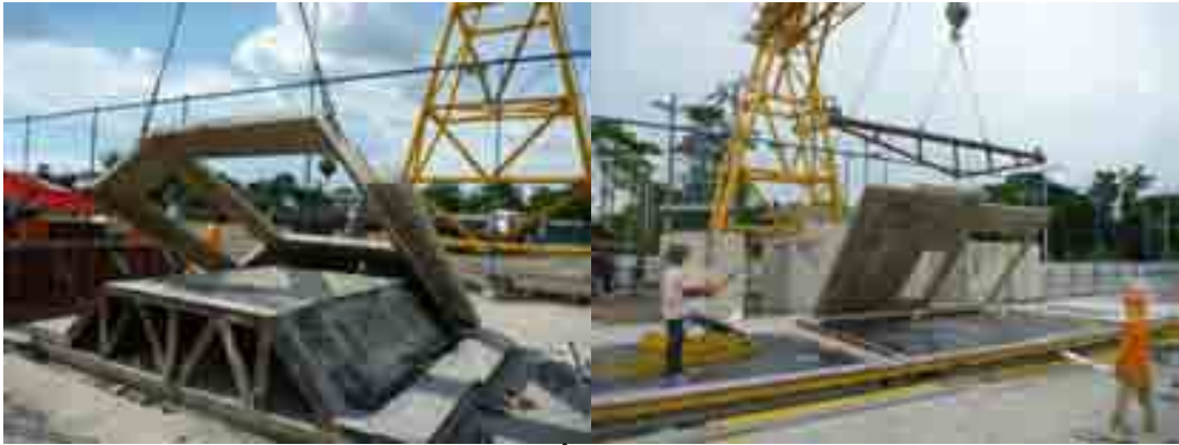
ภาพที่ 5-77 การยกชิ้นส่วนคอนกรีตสำเร็จรูป
