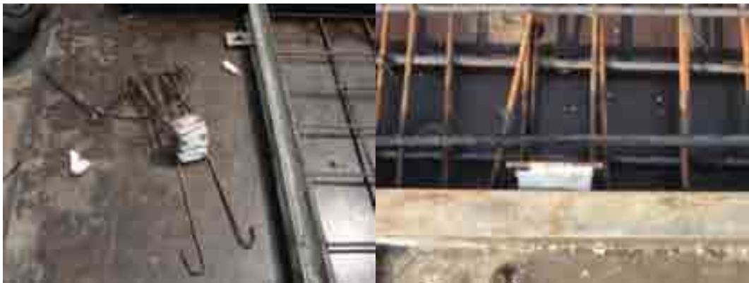
ภาพที่ 5-64 การวางเหล็กฝังในแบบหล่อ
