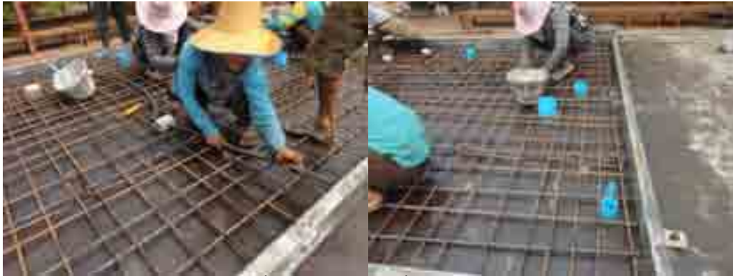
ภาพที่ 5-72 การติดตั้งงานระบบฝังในชั้นส่วนผนังคอนกรีตสำเร็จรูป
