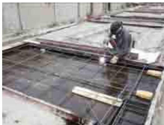
ภาพที่ 5-12 การทำบล็อกรับเชื่อมเหล็ก Tie bar สำหรับติดตั้งชั้นส่วนที่ฝังในแบบหล่อ
