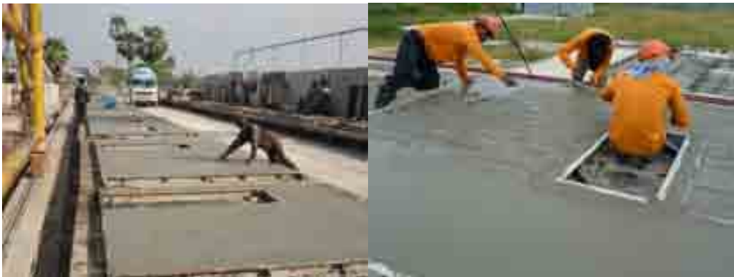
ภาพที่ 5-75 การแต่งผิวคอนกรีตและขึ้นส่วนที่มีรายละเอียดพิเศษ
