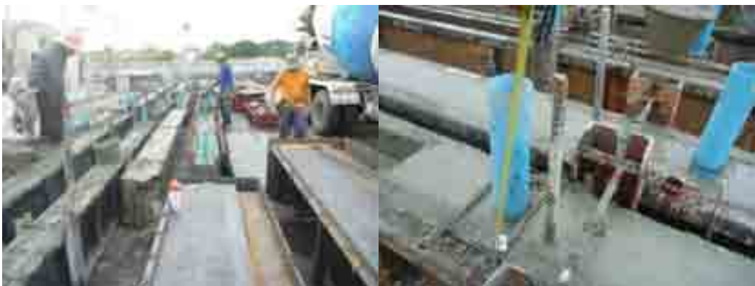
ภาพที่ 5-76 การหล่อคานคอดินสำเร็จรูป
