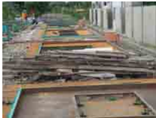
ภาพที่ 5-14 การเตรียมแบบหล่อ
