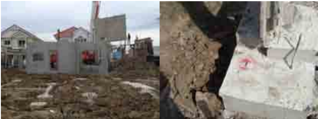
ภาพที่ 5-35 งานติดตั้งผนังชั้น 1
