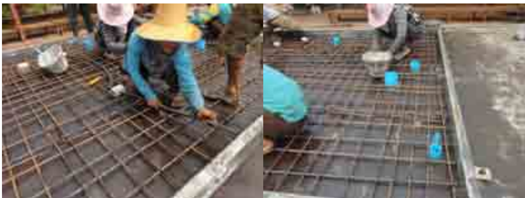
ภาพที่ 5-18การติดตั้งงานระบบฝังในชั้นส่วนผนังคอนกรีตสำเร็จรูป
