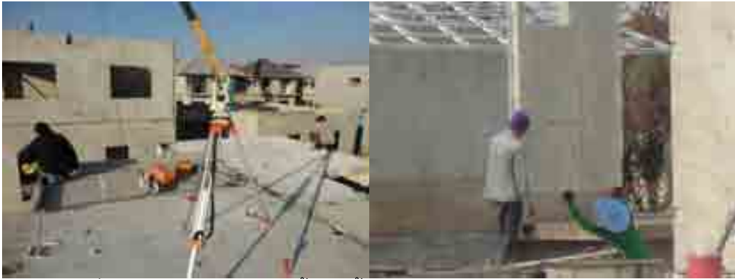
ภาพที่ 5-108 การตีเส้นแนวติดตั้งผนังชั้น 2 และตรวจสอบตำแหน่งเหล็ก Tie bar
