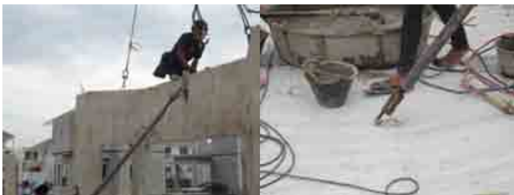
ภาพที่ 5-96 งานยึด-ค้ำยันผนังชั้น 1
