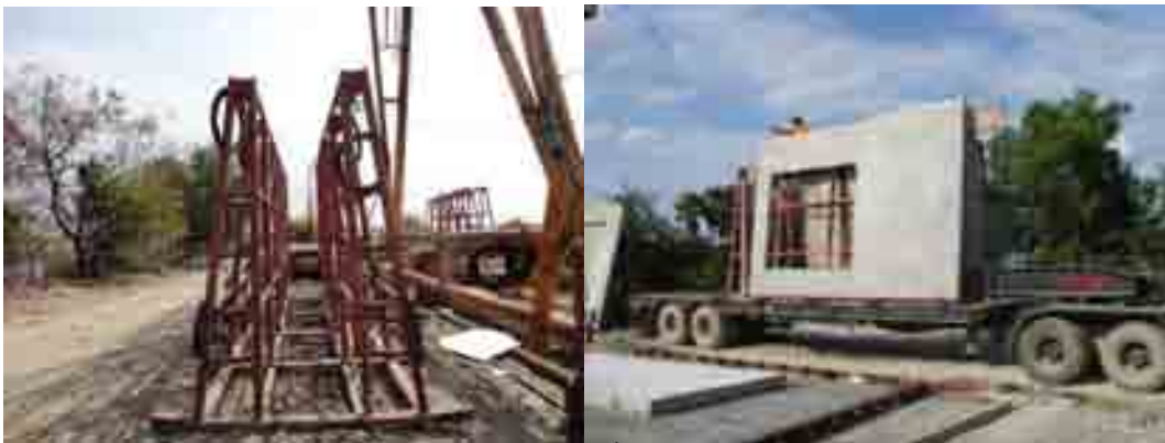
ภาพที่ 5-7 อุปกรณ์ใช้สำหรับวางชิ้นส่วนสำเร็จรูปบนรถบรรทุก
