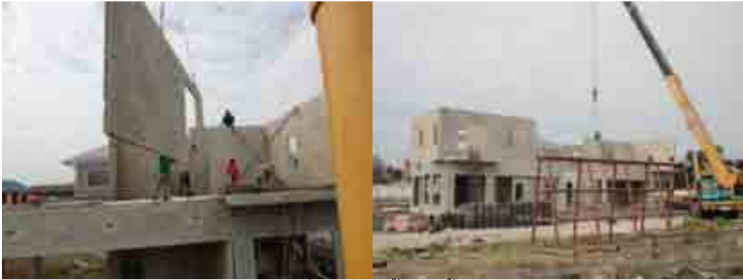
ภาพที่ 5-48 ติดตั้งผนังชั้น 2
