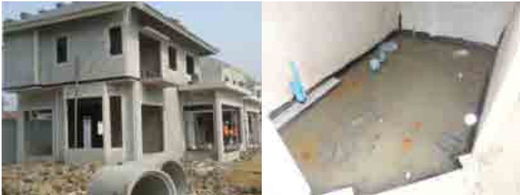
ภาพที่ 5-54 ทาน้ำยากันซึมตามรอยต่อระหว่างชิ้นส่วนต่างๆและทดสอบขังน้ำหารอยรั่ว
