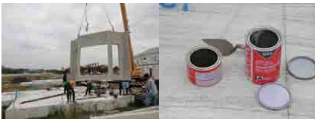
ภาพที่ 5-94 งานปรับแก้ตำแหน่งสอดเหล็ก Tie bar ผนังชั้น 1
