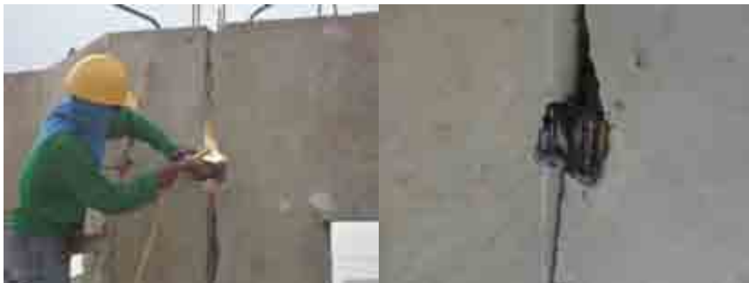
ภาพที่ 5-98 งานเชื่อมยึดระหว่างผนังชั้น 1
