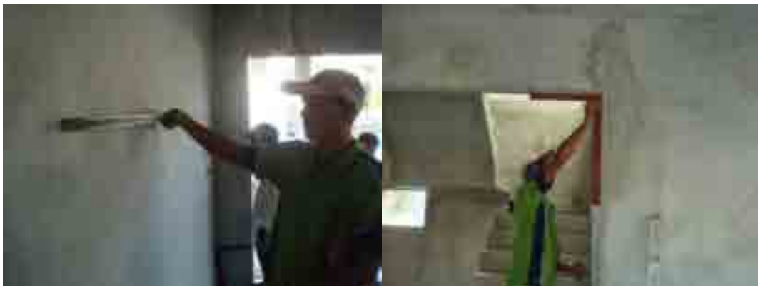
ภาพที่ 5-55 การตรวจสอบคุณภาพการติดตั้งชิ้นส่วนคอนกรีตสำเร็จรูป
