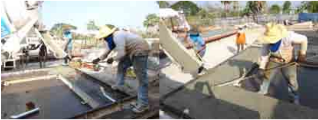
ภาพที่ 5-74 การเทคอนกรีตลงในแบบหล่อ
