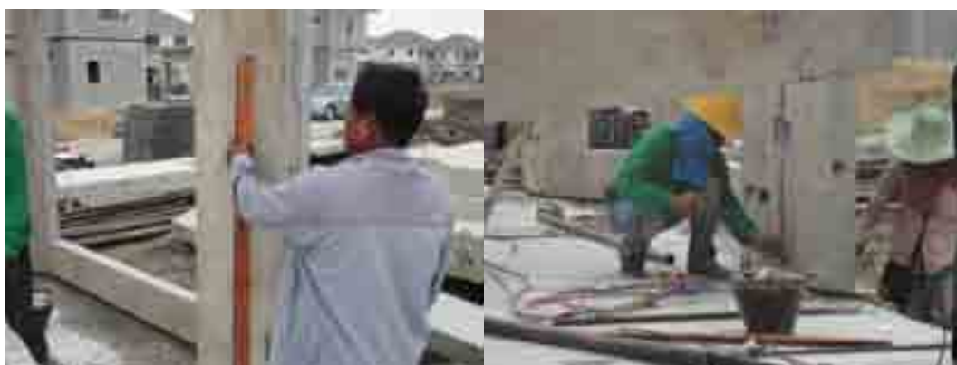
ภาพที่ 5-97 งานตรวจสอบระดับผนังชั้น 1
