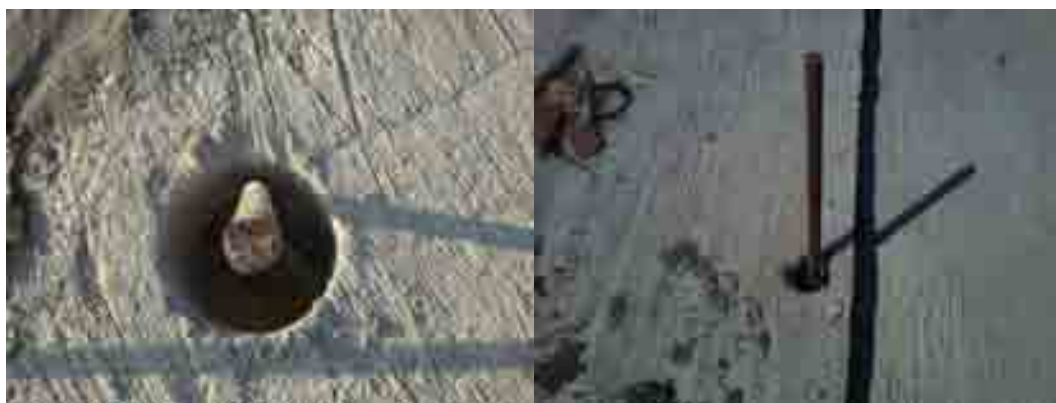
ภาพที่ 5-104 การวางจุดเชื่อมต่อระหว่างพื้นชั้น 2 และผนังชั้น 1 ให้ตรงกัน
