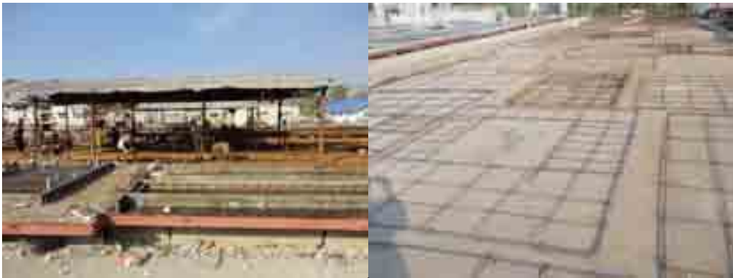
ภาพที่ 5-58 โรงตัดและลานขึ้นรูปงานเหล็กเสริมคอนกรีต
