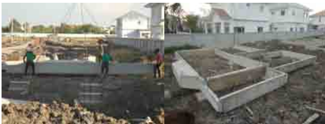
ภาพที่ 5-88 งานติดตั้งคานคอดิน
