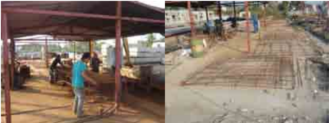
ภาพที่ 5-63 การทำเหล็กสำหรับเสริมในชั้นส่วนคอนกรีตสำเร็จรูป
