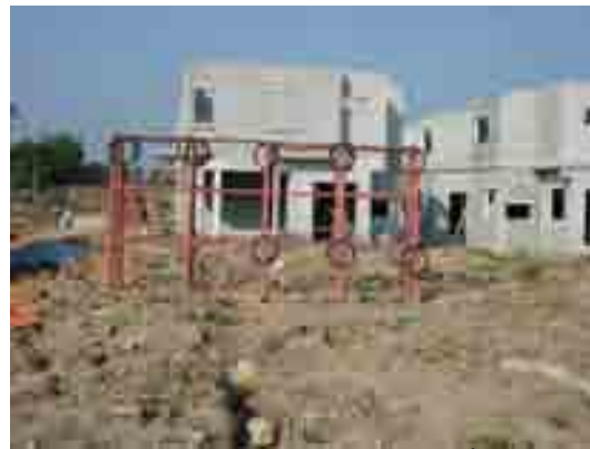
ภาพที่ 5-29 อุปกรณ์ A-FRAMEที่ใช้สำหรับจัดเรียงชิ้นส่วนชั่วคราวที่หน้างาน
