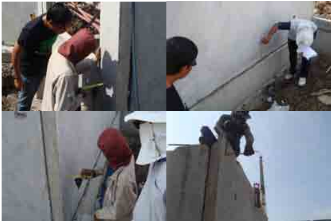
ภาพที่ 5-36 ตรวจสอบระดับการติดตั้งผนังชั้น 1
