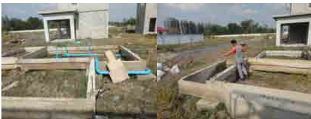
ภาพที่ 5-90 งานระบบและงานกำจัดปลวก
