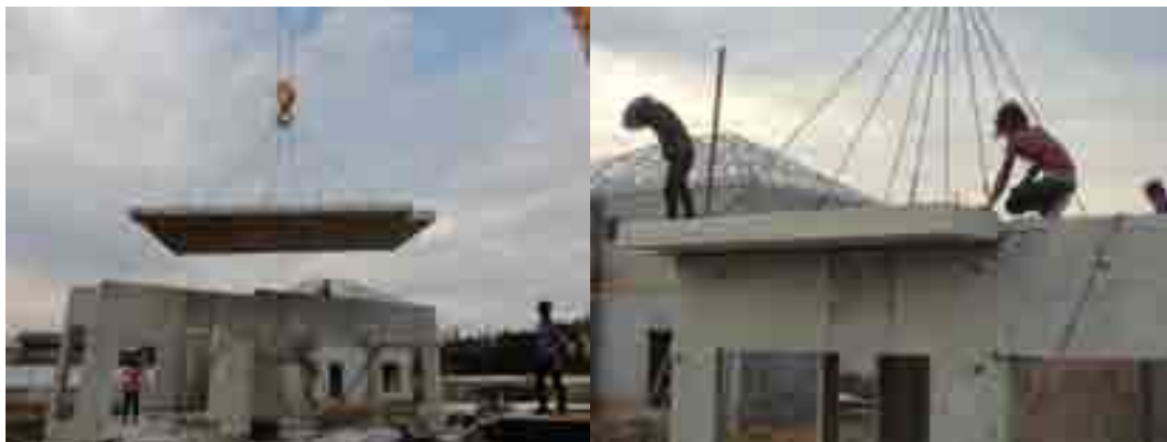
ภาพที่ 5-103 การยกชิ้นส่วนพื้นชั้น 2 เพื่อติดตั้ง
