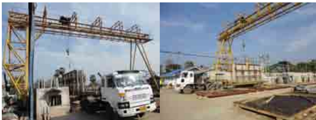
ภาพที่ 5-62 อุปกรณ์ใช้สำหรับวางชิ้นส่วนสำเร็จรูปบนรถบรรทุก
