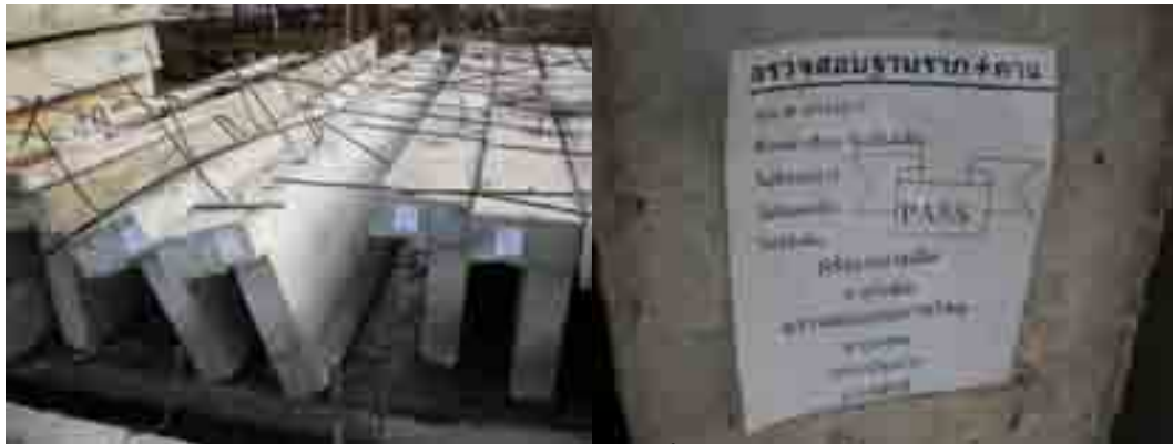
ภาพที่ 5-115 การตรวจสอบคุณภาพชิ้นส่วนคอนกรีตสำเร็จรูป
