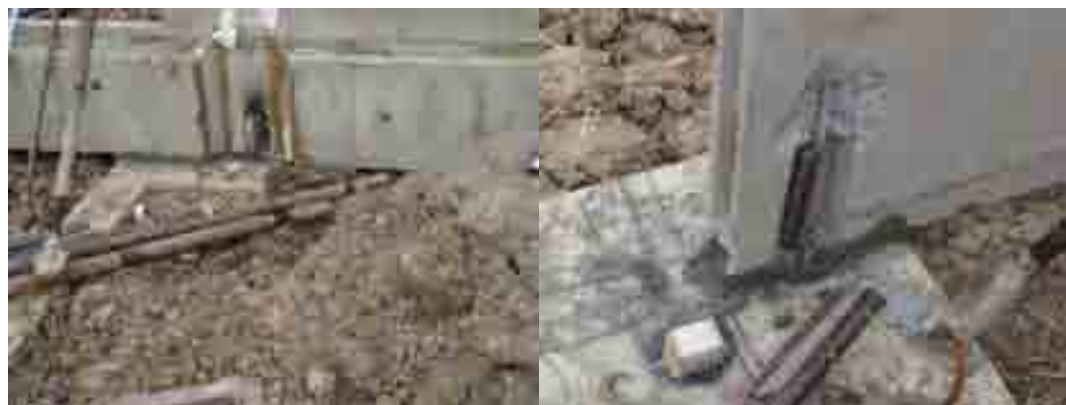
ภาพที่ 5-38 งานเชื่อมยึดระหว่างผนังชั้น 1 กับฐานราก
