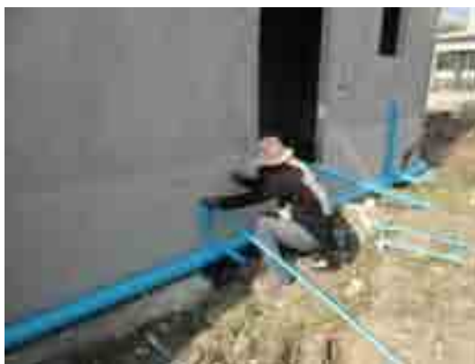
ภาพที่ 5-113 ติดตั้งงานระบบประปา
