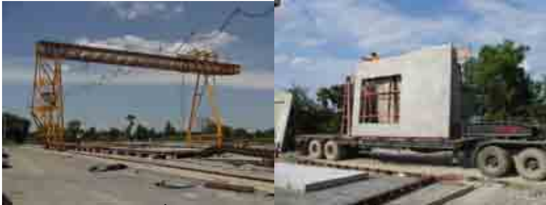
ภาพที่ 5-23 การขนส่งชิ้นส่วนด้วยเครนภายในโรงงานผลิตชิ้นส่วนคอนกรีตสำเร็จรูป
