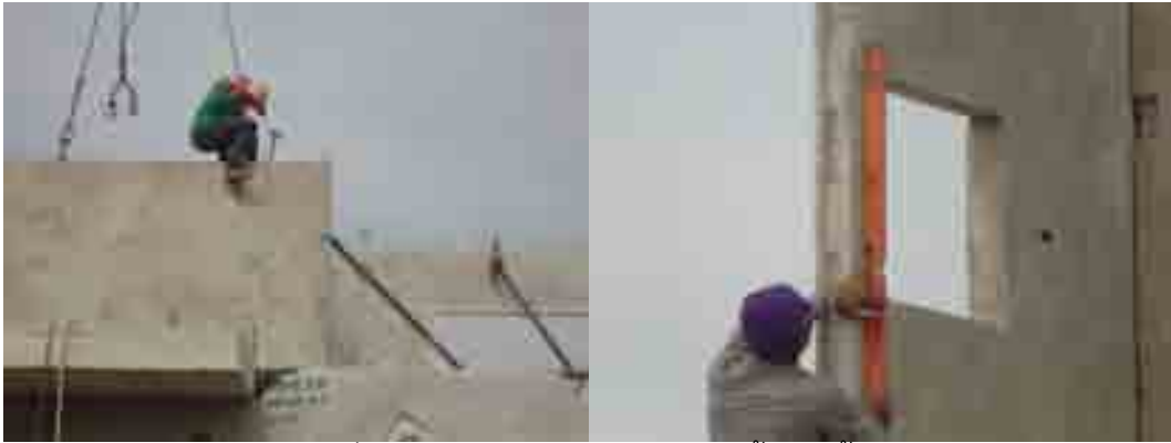
ภาพที่ 5-110 ตรวจสอบระดับการติดตั้งผนังชั้น 2
