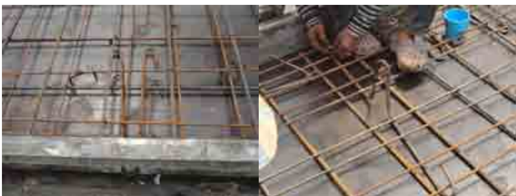
ภาพที่ 5-65 การเสริมเหล็กสำหรับยกชั้นส่วนที่ฝังในแบบหล่อ
