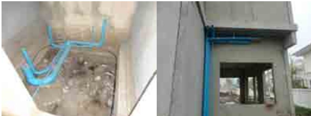
ภาพที่ 5-53 ติดตั้งงานระบบประปา
