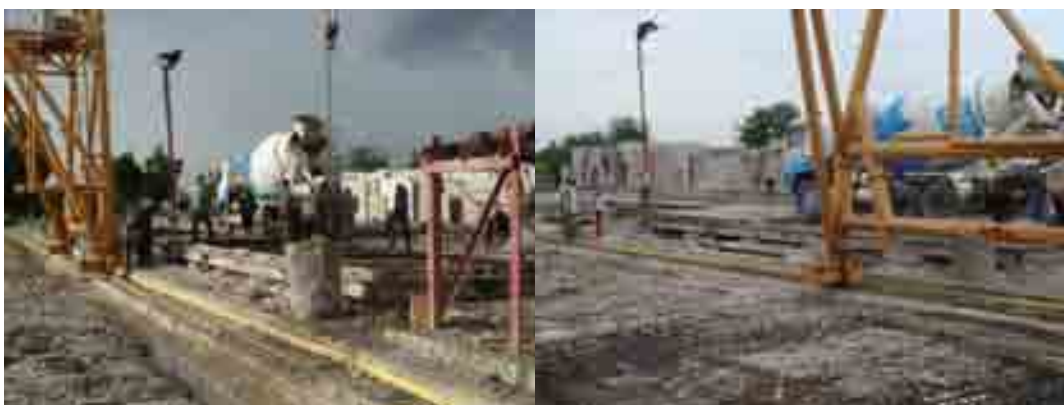
ภาพที่ 5-20 การเทคอนกรีตลงในแบบหล่อ
