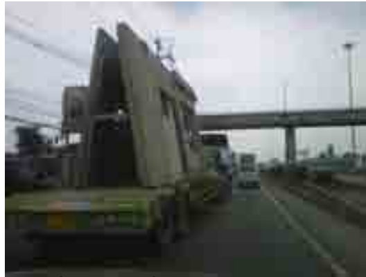
ภาพที่ 5-24 การขนส่งชิ้นส่วนผนังชั้น 1 ของโรง 1 บนรถทางเรียบหรือ low base
