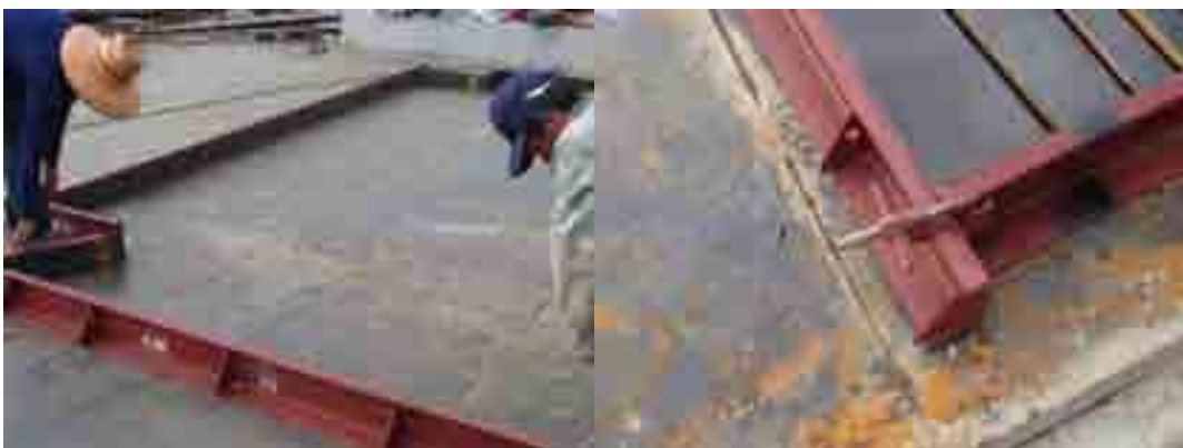
ภาพที่ 5-15 การเตรียมแบบหล่อผนังและการยึดแบบข้างชั้นส่วนผนังสำเร็จรูป
