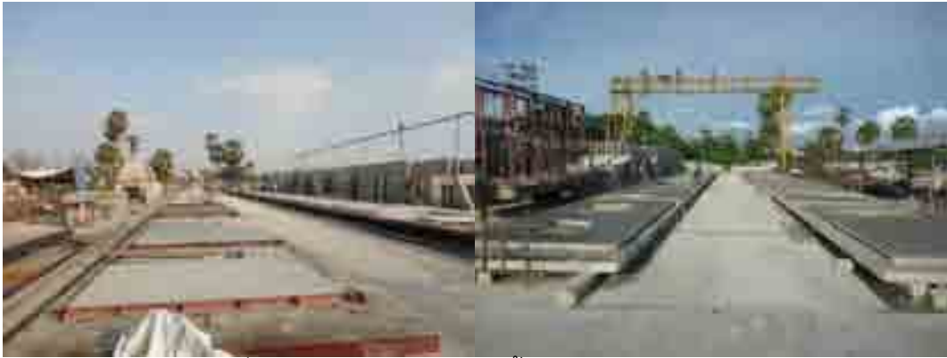
ภาพที่ 5-59 บริเวณสำหรับหล่อชิ้นส่วนคอนกรีตสำเร็จรูป
