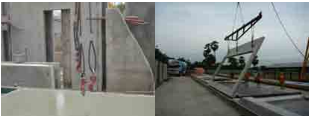
ภาพที่ 5-80 การใช้อุปกรณ์ในการยกขึ้นส่วน
