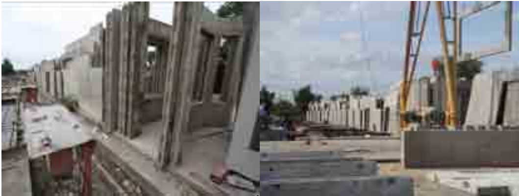
ภาพที่ 5-6 ส่วนจัดเก็บชิ้นส่วนคอนกรีตสำเร็จรูป
