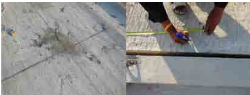
ภาพที่ 5-92 งานตีเส้นแนวติดตั้งผนังที่พื้นชั้น 1
