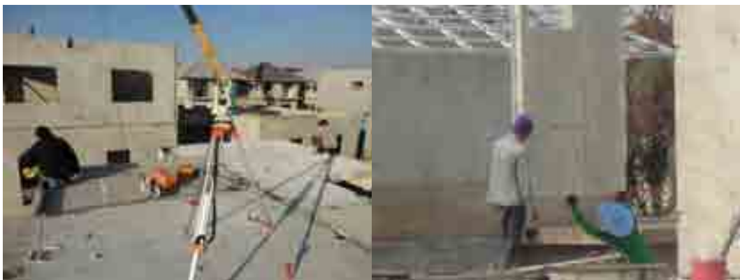
ภาพที่ 5-47 ตีเส้นแนวติดตั้งผนังชั้น 2 และตรวจสอบตำแหน่งเหล็ก Tie bar
