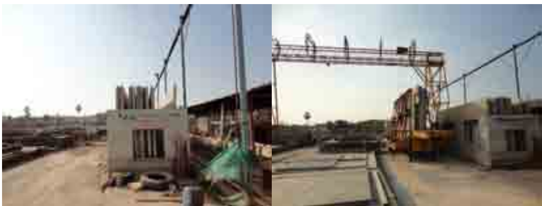
ภาพที่ 5-61 ส่วนจัดเก็บชิ้นส่วนคอนกรีตสำเร็จรูป
