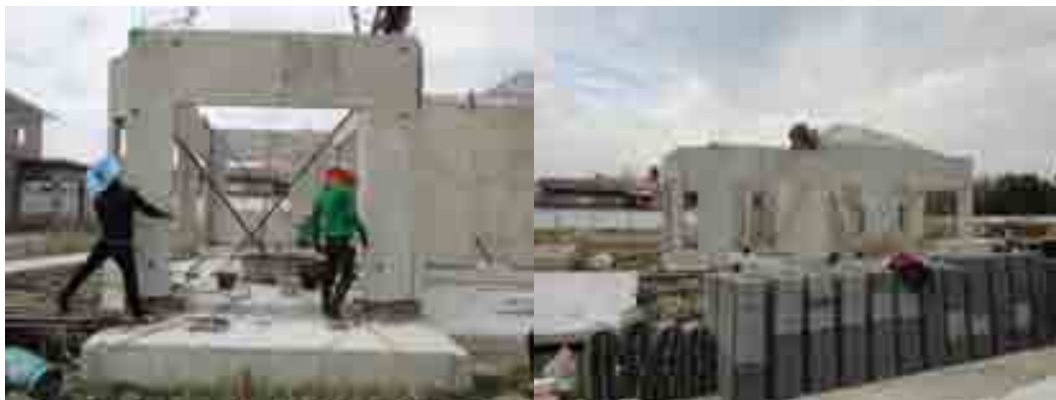
ภาพที่ 5-95 งานติดตั้งผนังชั้น 1
