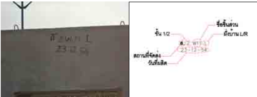
ภาพที่ 5-78 การทำสัญลักษณ์และวันที่ผลิตบนชิ้นส่วนคอนกรีตสำเร็จรูป
