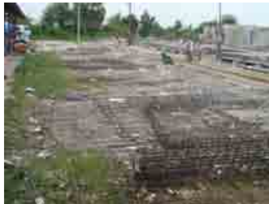
ภาพที่ 5-9 การเตรียมเหล็กเสริมเพื่อรอติดตั้งในแบบหล่อชิ้นส่วน
