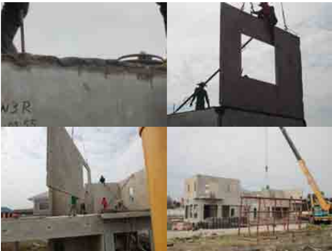
ภาพที่ 5-109 ติดตั้งผนังชั้น 2
