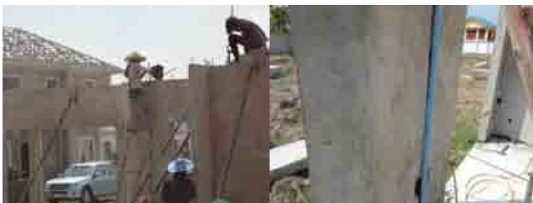
ภาพที่ 5-100 งานเทคอนกรีตเชื่อมรอยต่อ(joint)ผนัง
