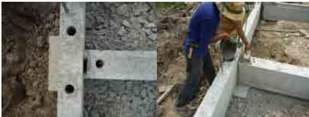
ภาพที่ 5-89 การยี่ดระหว่างคานคอดินและฐานราก
