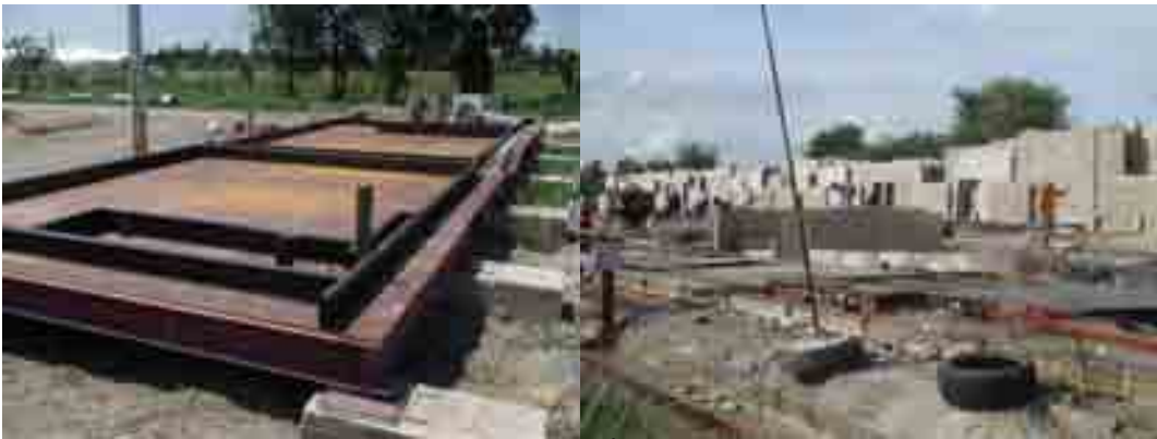
ภาพที่ 5-4 บริเวณสำหรับหล่อชิ้นส่วนคอนกรีตสำเร็จรูป
