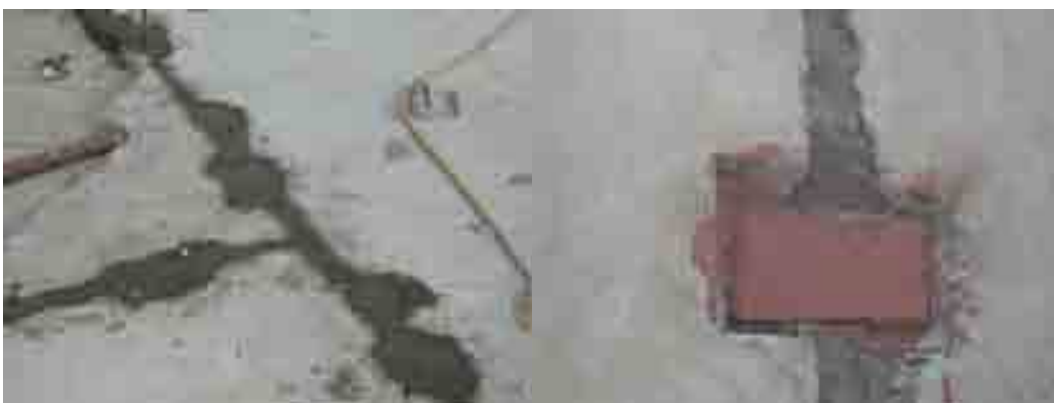
ภาพที่ 5-107 การเก็บงานเชื่อมต่อน้ขึ้นส่วนสำเร็จรูป
