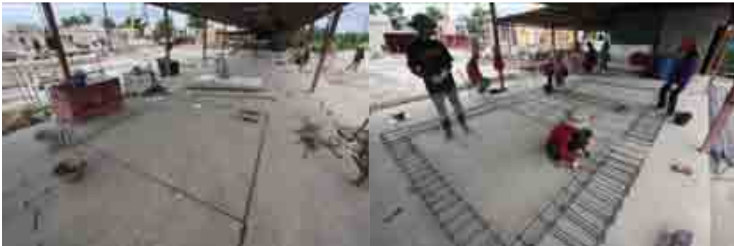
ภาพที่ 5-8 การทำเหล็กเสริมสำหรับชิ้นส่วนคอนกรีตสำเร็จรูป
