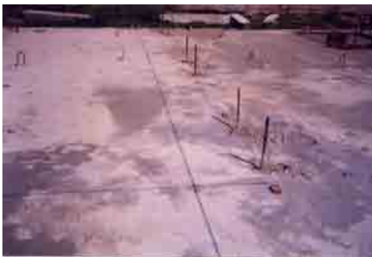
ภาพที่ 2-10 แสดงเส้น OFF - SET GRID - LINE และแนวผนัง P.C.
