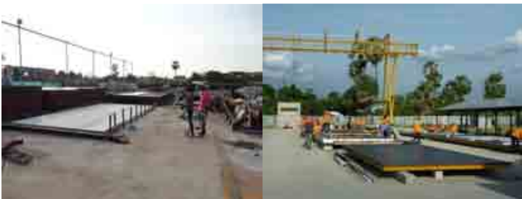
ภาพที่ 5-68 การทำฐานรองแบบหล่อ
