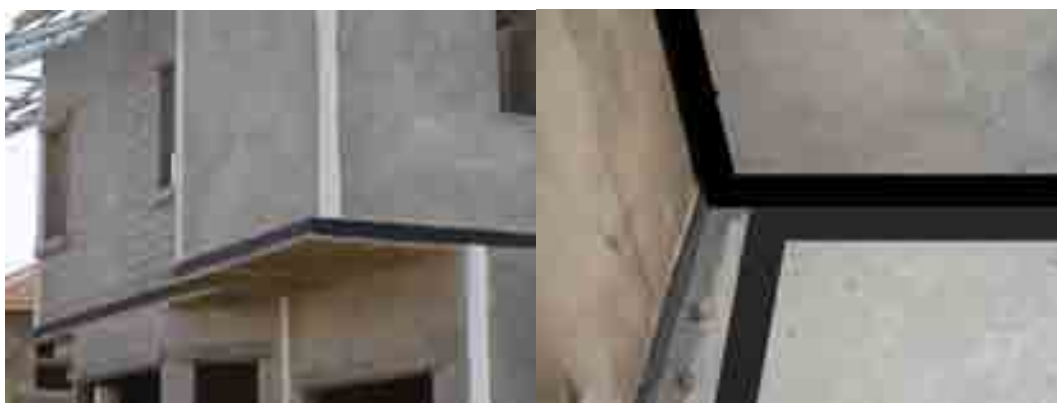
ภาพที่ 5-114 ทาน้ำยากันซึมตามรอยต่อระหว่างชิ้นส่วนต่างๆ
