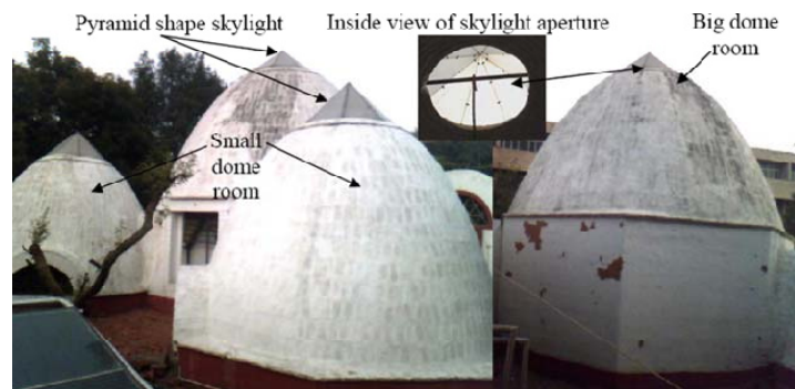
รูปที่ 2.13 แสดงรูปแบบหลังคา Skylight ที่เปิดรับแสงธรรมชาติ
