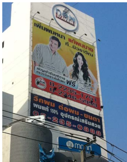
ภาพที่ 2 แสดงป้ายติดตั้งด้านนอกอาคาร
