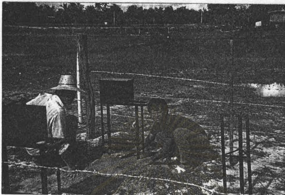
รูปที่ ง-5 การติดตั้งอุปกรณ์ตรวจวัดภูมิอากาศ
