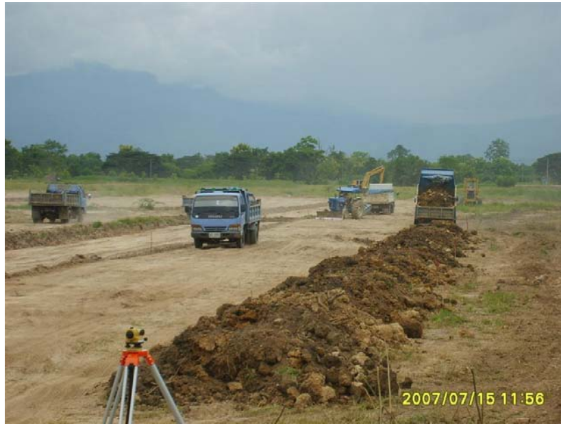
ภาพที่ 5.8 แสดงการใช้รถดินดินที่ไม่เหมาะสมกับประเภทงาน
