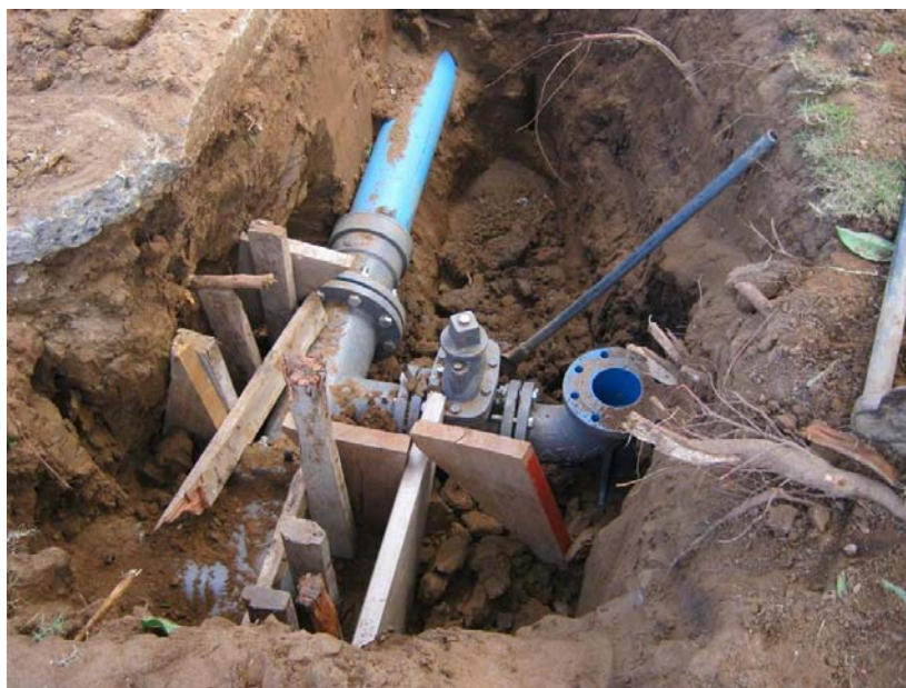
ภาพที่ 5.68 ปัญหาพื้นที่คับแคบเป็นอุปสรรคต่อการวางท่อและระบบประปา ผลที่ตามมา
