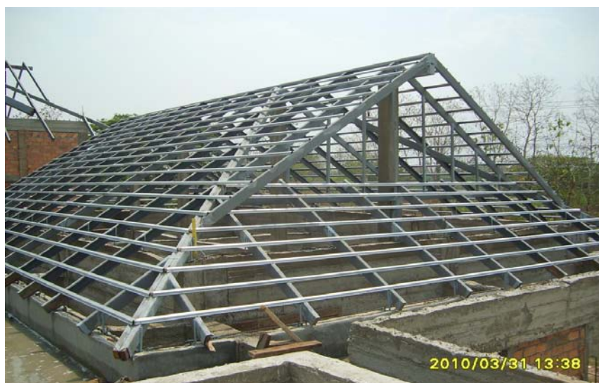
ภาพที่ 5.45 แสดงการทำโครงหลังคา ให้ได้แนวระยะการติดตั้งแปตามมาตรฐานของกระเบื้อง
