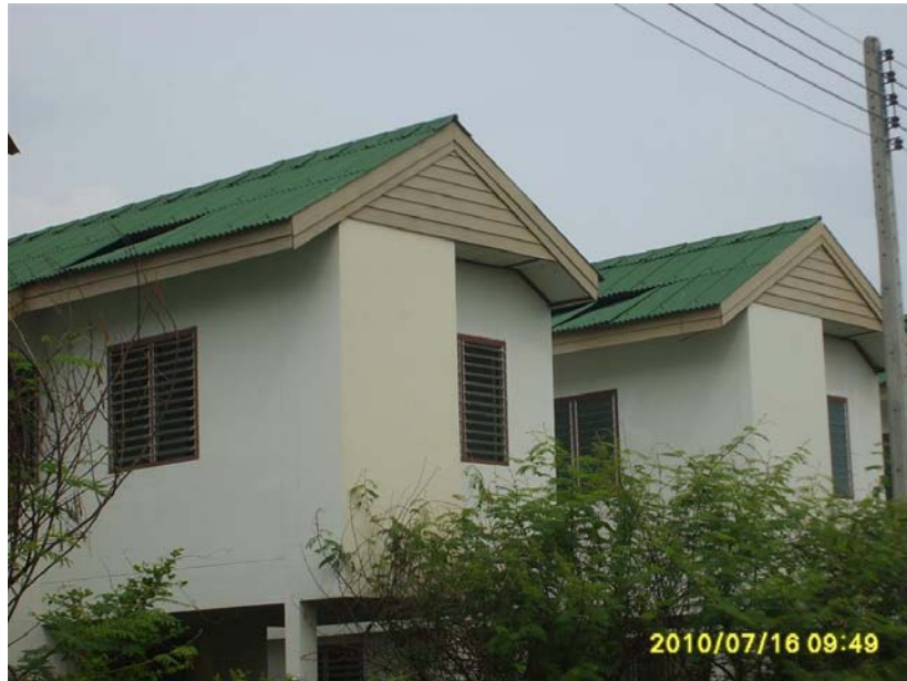
ภาพที่ 5.42 แสดงปัญหากระเบื้องหลังคาหลุดเสียหาย
