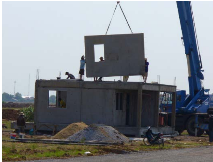
ภาพที่ 5.37 แสดงการติดตั้งระบบผนังสำเร็จรูป
