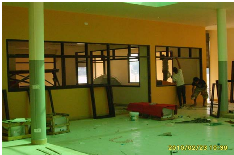
ภาพที่ 5.55 แสดงการทำงานติดตั้งประตู – หน้าต่าง
