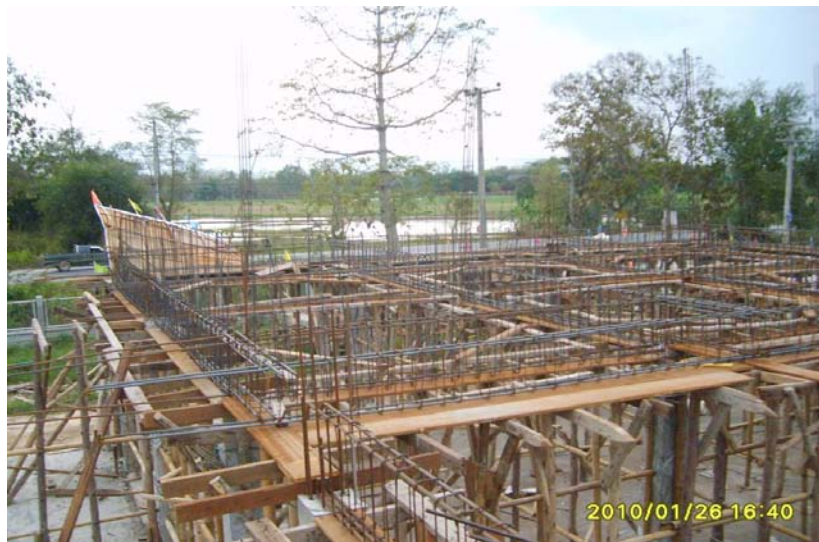
ภาพที่ 5.31 แสดงการทำงานแบบหล่อในที่
