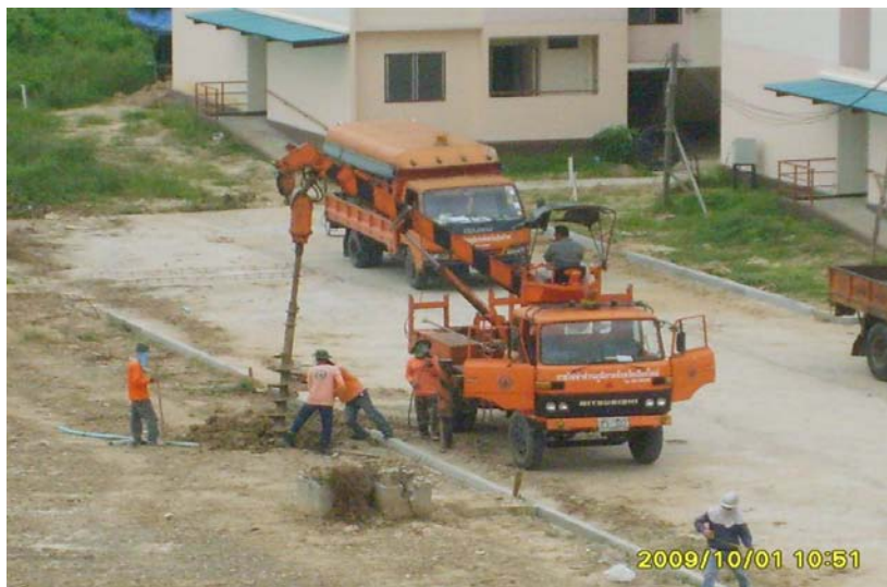
ภาพที่ 5.64 แสดงการทำงานปักเสาไฟฟ้า
