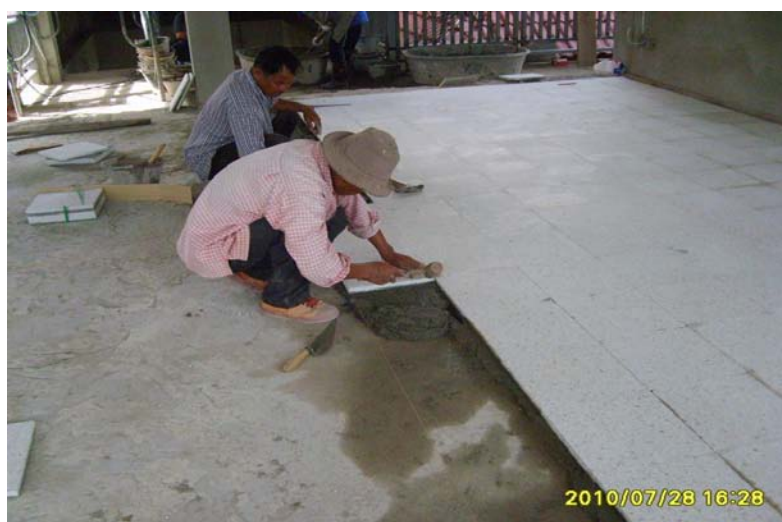
ภาพที่ 5.53 แสดงการทำงานปูแผ่นพื้นกระเบื้อง
