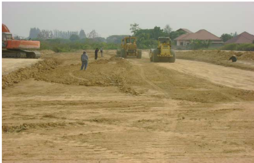
ภาพที่ 5.6 แสดงการถมดินในสถานที่ก่อสร้าง
