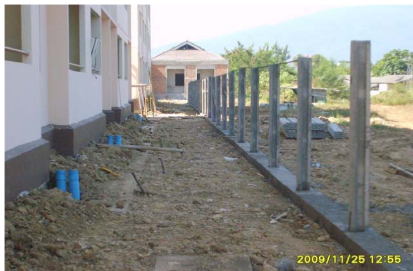
ภาพที่ 5.19 แสดงการทำงานรั้วแบบไม่มีกำแพงกันดิน
