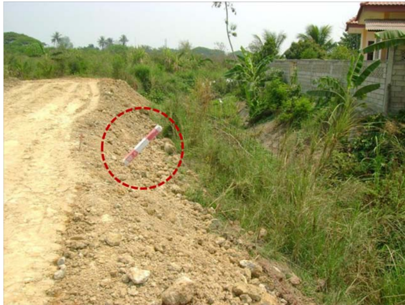
ภาพที่ 5.5 แสดงหมุดหลักเขตเสียหายระหว่างการถมดิน
