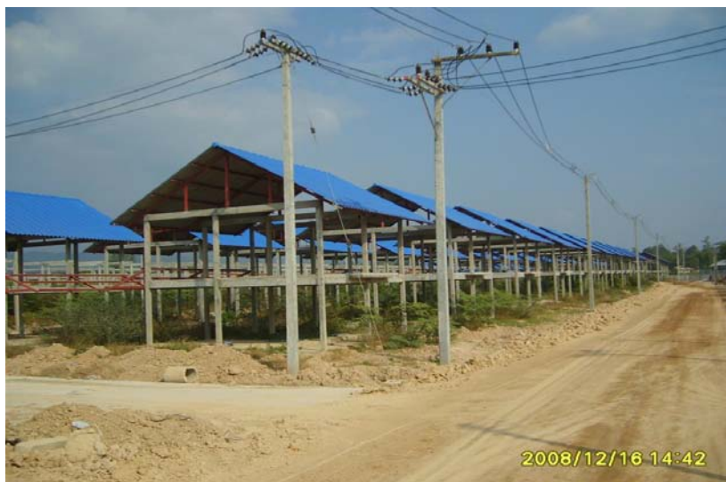
ภาพที่ 5.65 แสดงการทำงานพาดสายไฟฟ้า
