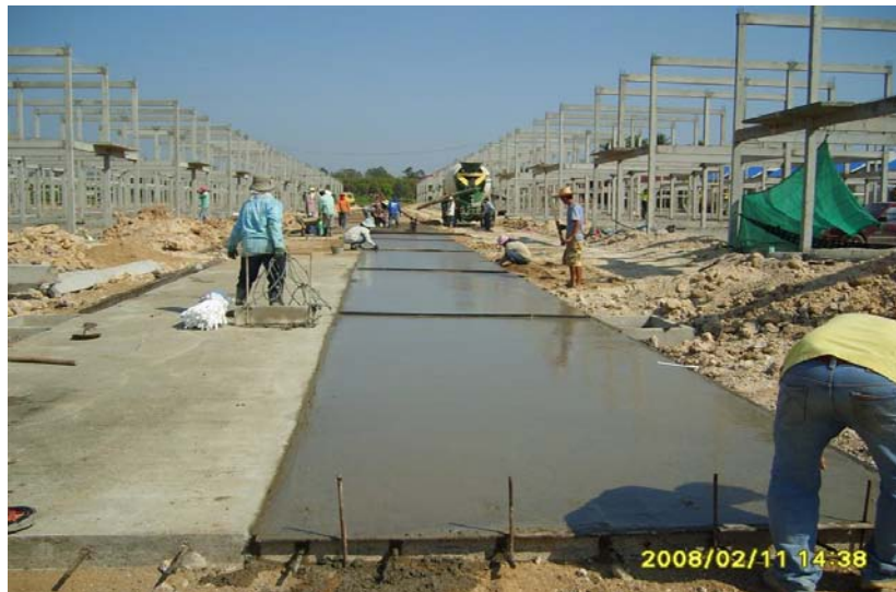
ภาพที่ 5.15 แสดงการทำงานผิวถนนคอนกรีต
