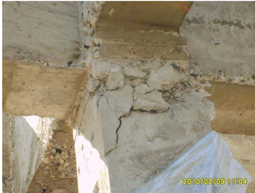
ภาพที่ 5.34 แสดงการแตกร้าวของตัวโครงสร้างระหว่างการทำงาน
