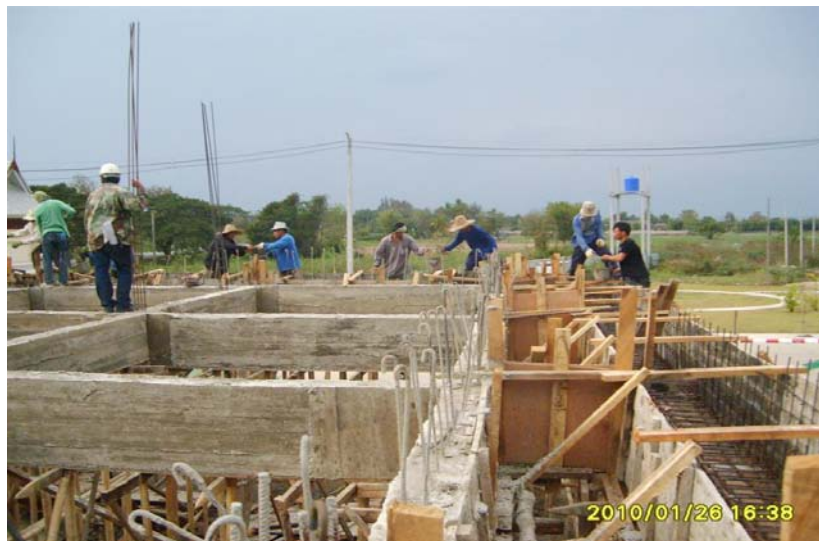
ภาพที่ 5.32 แสดงการทำงานแบบหล่อในที่
