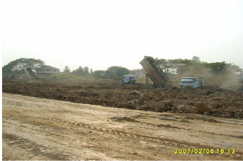
ภาพที่ 5.6 แสดงการถมดินในสถานที่ก่อสร้าง
