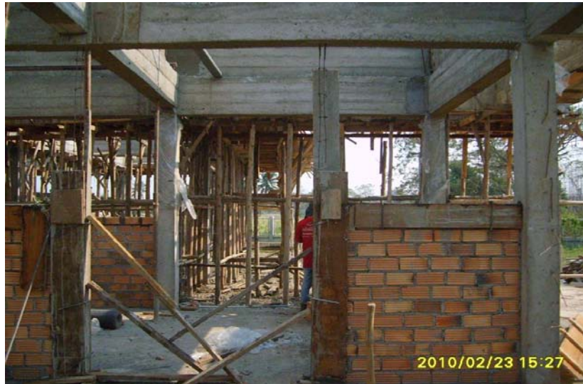
ภาพที่ 5.49 แสดงการทำงานผนังก่ออิฐ
