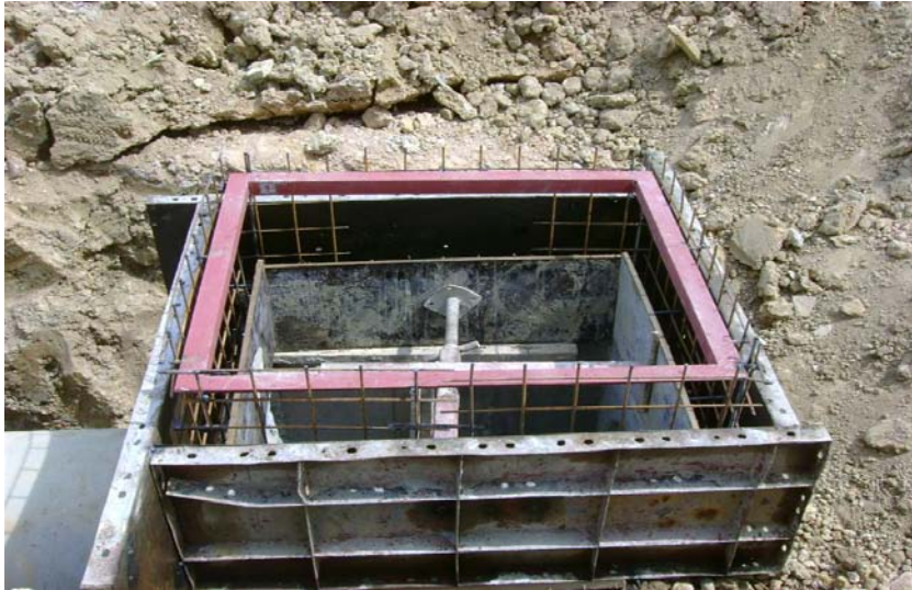
ภาพที่ 5.11 แสดงการทำงานงานบ่อพักน้ำ
