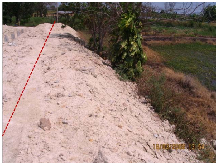
ภาพที่ 5.8 แสดงการใช้รถดินดินที่ไม่เหมาะสมกับประเภทงาน
