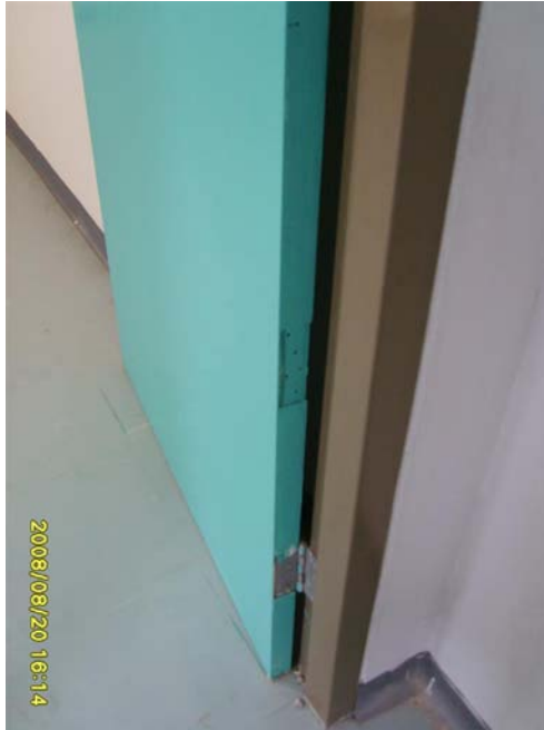
ภาพที่ 5.56 แสดงการทำงานติดตั้งอุปกรณ์ประตูผิด ผลที่ตามมา
