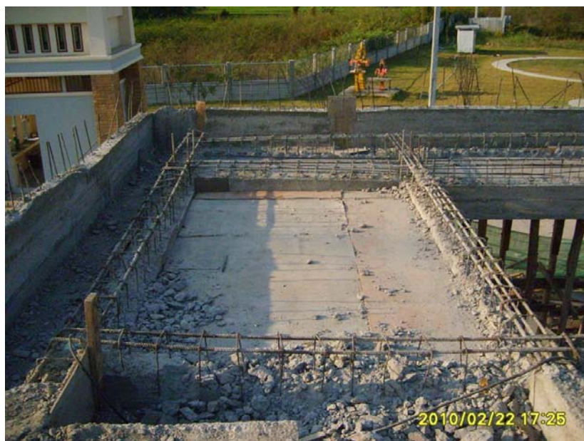
ภาพที่ 5.35 แสดงการทุบรีดในกรณีที่ไม่ได้ระดับตามแบบ
