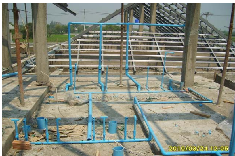
ภาพที่ 5.62 แสดงการทำงานเดินระบบท่อน้ำภายในอาคาร
