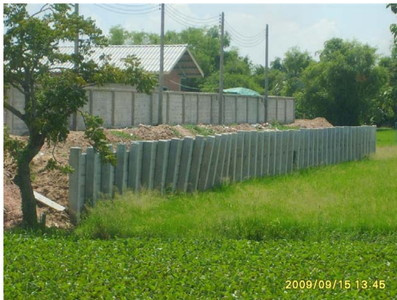
ภาพที่ 5.20 แสดงกำแพงกันดินที่ชำรุด ล้มเอียง
