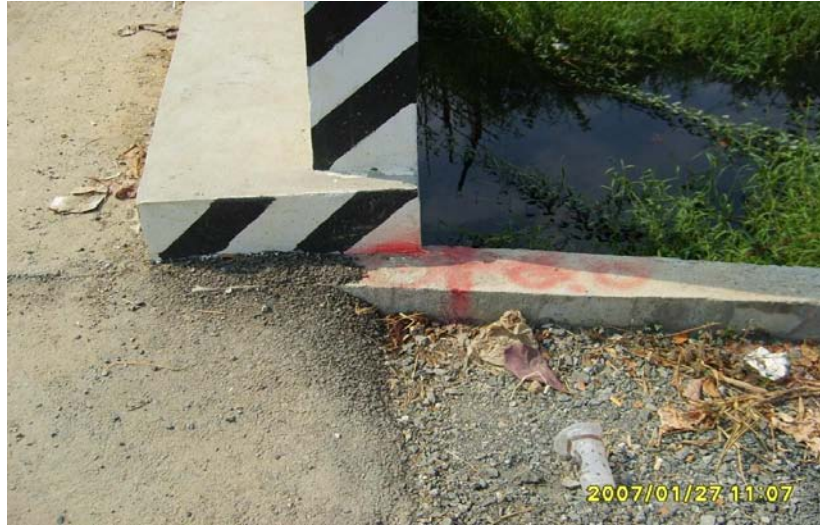
ภาพที่ 5.1 แสดงตัวอย่างค่าระดับ BM.ที่กำหนดไว้ในสถานที่ก่อสร้าง
