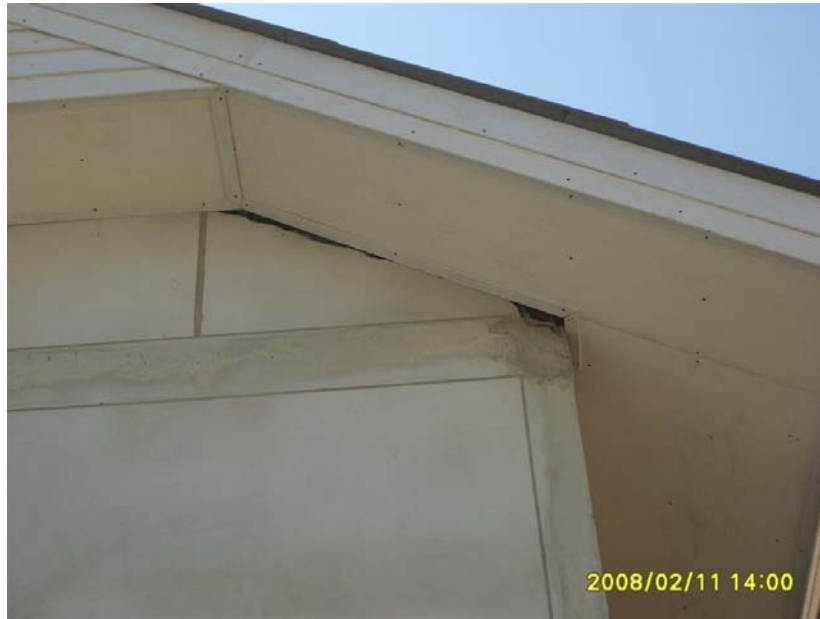
ภาพที่ 5.51 แสดงการฉาบปูนที่ไม่ได้ระดับ
