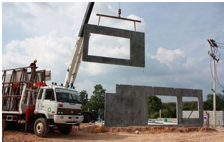
ภาพที่ 5.40 แสดงการบริหารจัดการที่ดีโดยขนส่งชิ้นส่วนสำเร็จรูปพร้อมติดตั้งทันที
