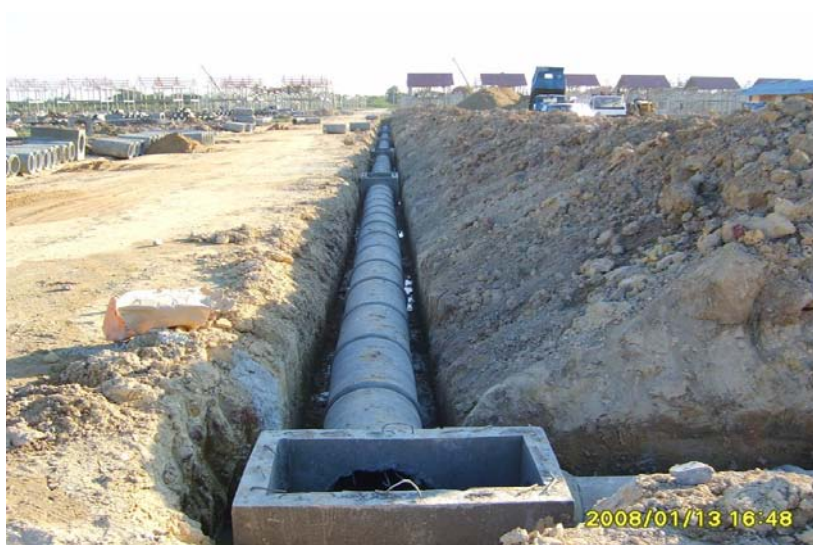
ภาพที่ 5.10 แสดงการวางท่อระบายน้ำ
