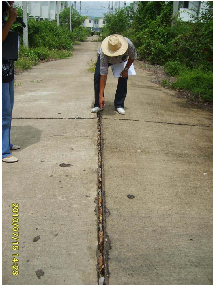
ภาพที่ 5.16 แสดงการทรุดตัวของถนนตามบริเวณรอยต่อ
