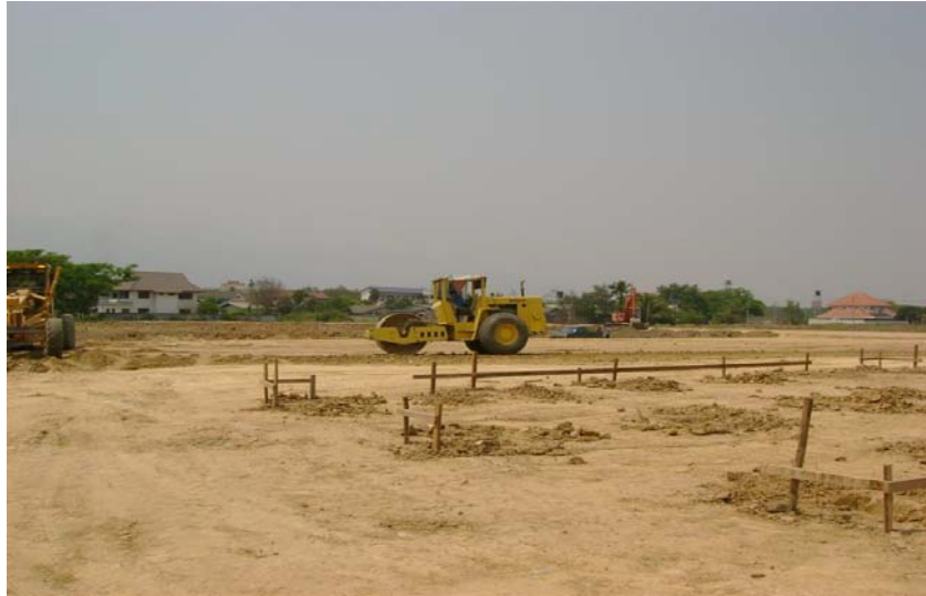
ภาพที่ 5.14 แสดงการบดอัดชั้นรองพื้นทาง
