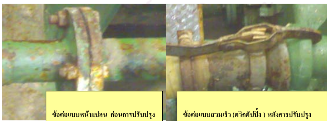
รูปที่ 4.12 การใช้ข้อต่อแบบหน้าแปลน และแบบสวมเร็ว (ควิกคัปปีง) ในโรงงานตัวอย่าง
