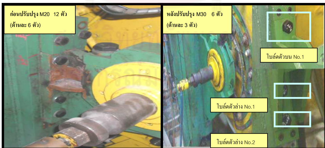
รูปที่ 4.9 การทดลองการลดจำนวนโบลต์ลงเหลือ 6 ตัว โดยแต่ละด้านจะมีโบลต์ 3 ตัว โดยยึดโบลต์ด้านล่าง 2 ตัวและด้านบน 1 ตัว เพื่อรับแรงเหวี่ยงในลูกอัด
