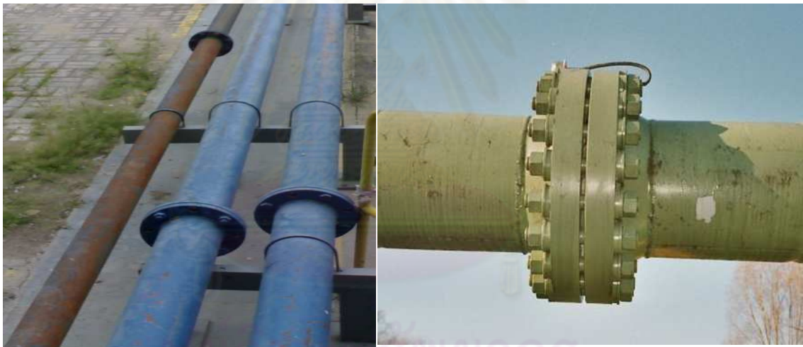
รูปที่ 2.6 ลักษณะข้อต่อแบบหน้าแปลน
