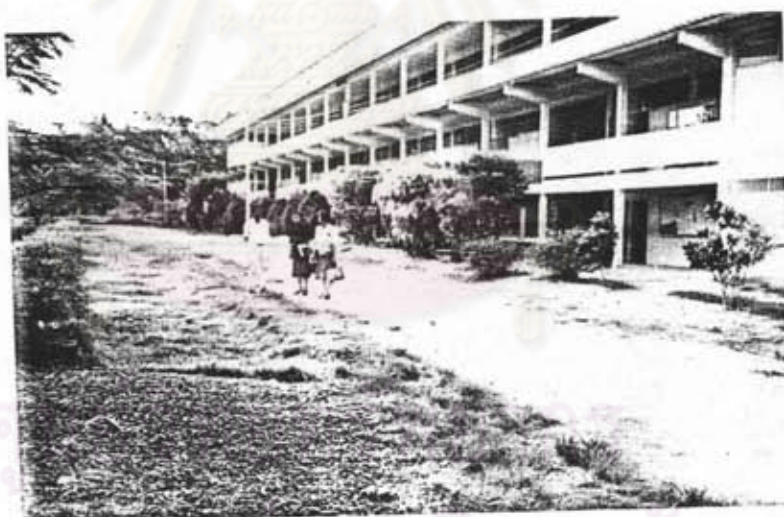
10. อาคารเรียน ที่ต่อเติมแล้ว
