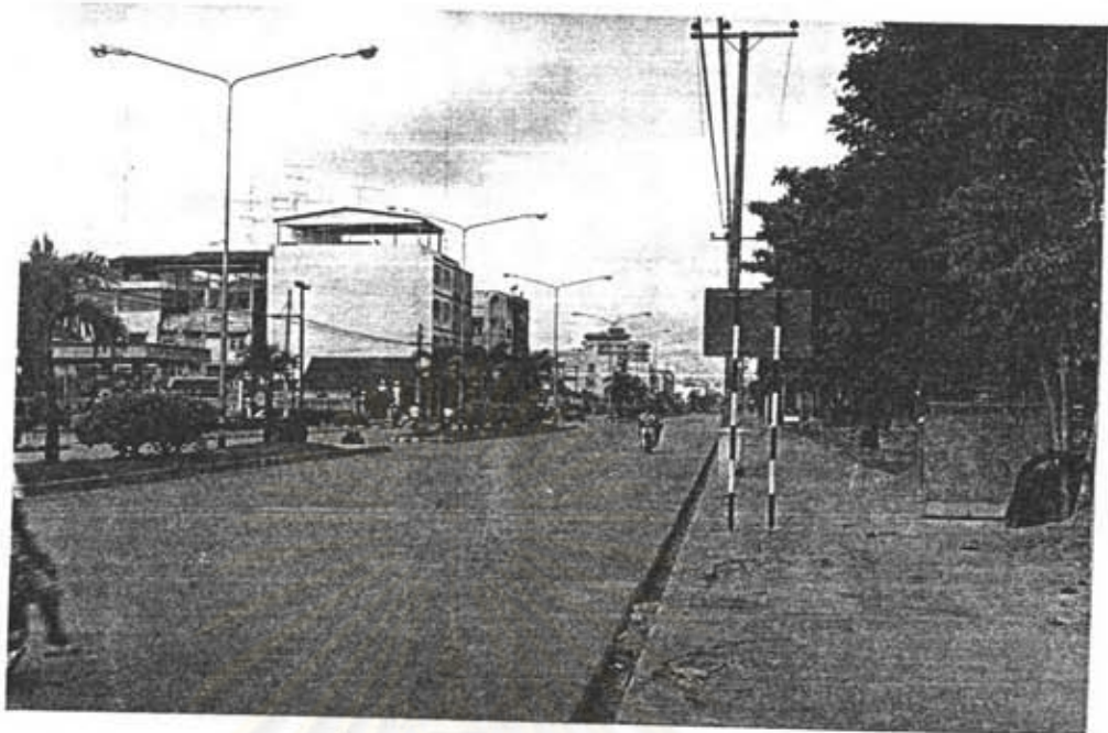
รูปที่ 4.5 สภาพถนนท่าแฉลบ
