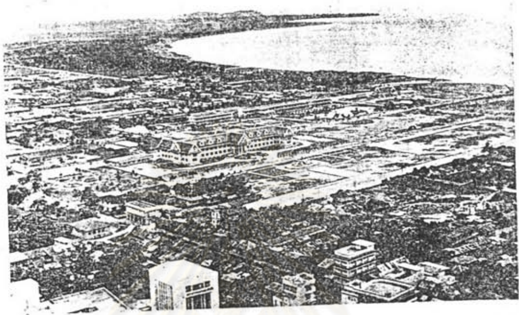
ภาพที่ จ ๖ บริเวณที่ก่อสร้างศาลากลางจังหวัด โรงเรียนชลกัลยานุกุล และที่ว่าการอำเภอ เมืองชลบุรีหลังใหม่ เคยเป็นทะเลมาก่อนทั้งสิ้น จังหวัดได้ทำการปรับปรุง จนสามารถปลูกสร้างอาคารของทางราชการได้
