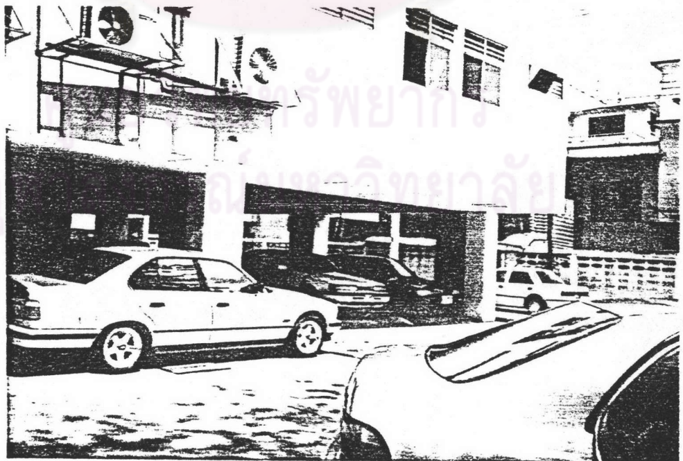
ภาพที่ 3.13 สถานที่จอดรถ ชั้นล่างของอาคารบางรักคอนโดมิเนียม
