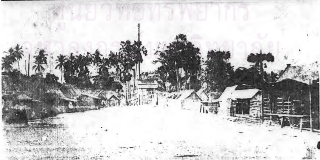
ภาพเก่าจากหอจดหมายเหตุแห่งชาติ สภาพประตูและป้อมมุมเมืองในอดีต ภาพล่างบริเวณประตู ทำแพขึ้นนอก บนถนนทำแพ สิ่งเกิดอาคารริมถนนทั้งสองด้าน.
