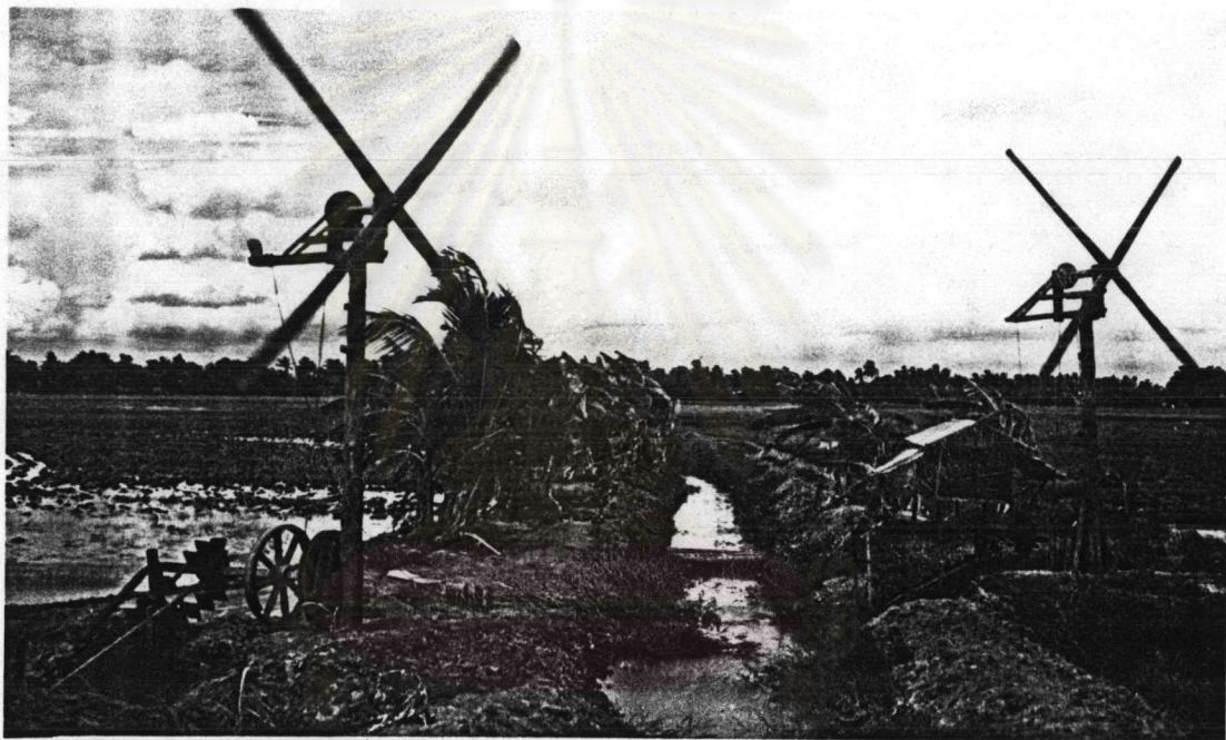
รูปที่ 1-1 กังหันลมแบบใบพัดทำด้วยไม้ ความเร็วรอบสูงใช้กับระหัดวิดน้ำเข้านาข้าว
