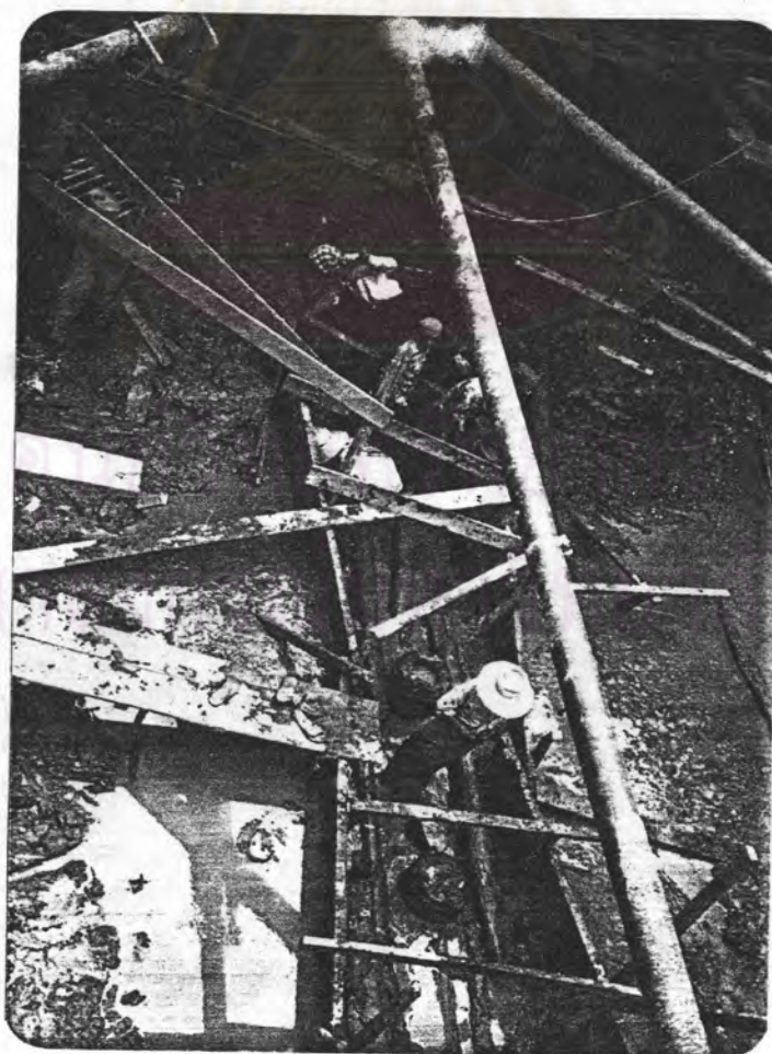
รูปที่ 5.3 รูปของการขุดดินในบริเวณพื้นดินใต้ท้องน้ำ แสดงการใช้ไม้กระดานป้องกันพื้นดินพังทลาย ในงานก่อสร้างคานเรือ ตัวอย่าง
