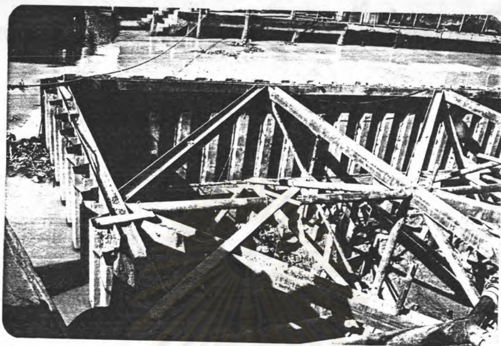
รูปที่ 5.2 รูปภาพของพื้นดินใต้ท้องน้ำหลังจากสูบน้ำเสร็จเรียบร้อยแล้ว ของงานก่อสร้างคานเรือตัวอย่าง
